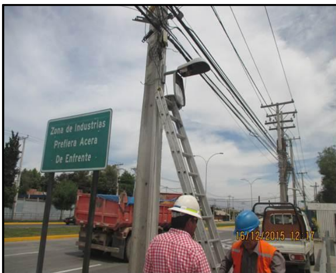
Mantenimiento a luminaria peatonal Av. Suiza PK. 0.379, oriente.
