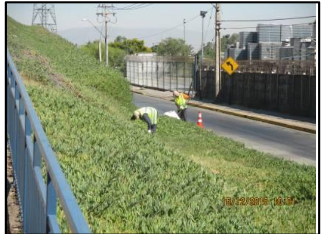
Limpieza y desmalezado cubresuelos Av. Suiza PK 0.530, oriente.
