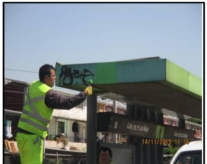
Limpieza de cubierta refugio peatonal Av. Las Rejas PK. 1.808, poniente.
