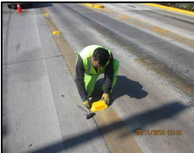
Instalación de tachones reflectantes Av. Las Rejas PK. 3.100, oriente.
