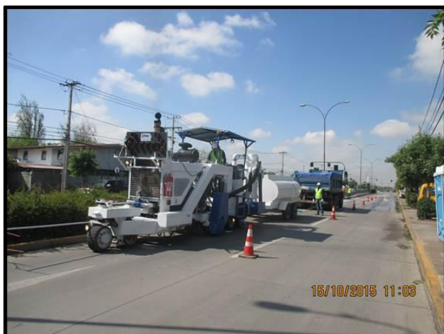
Cepillado de pavimentos Av. Las Rejas PK 3.055, poniente.
