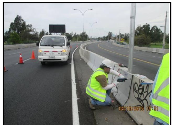
Reposición faldón metálico protección luminaria Emeres PK 1.016, mediana.
