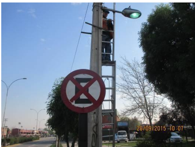
Reposición lámpara luminaria peatonal Av. Las Rejas PK 1.694, poniente.
