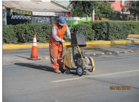
Limpieza de juntas
