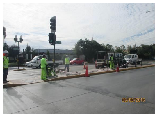
Reposición de vallas peatonales
