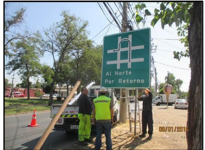
Reposición de señal informativa Av. 5 de Abril, calzada sur.
