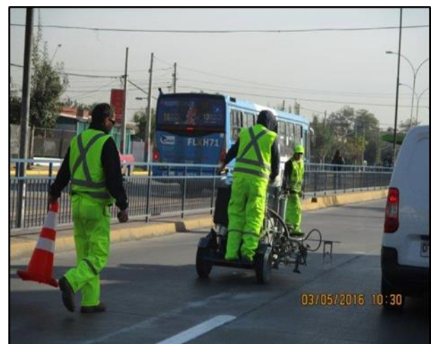
Demarcación Vial, Las Rejas Oriente.
