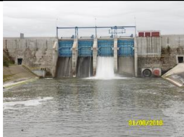
Presa Auxiliar, aguas abajo
