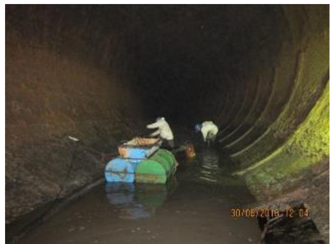
Limpieza de la Aducción del Túnel Sur. Con palas, agua y bomba de agua para sacar el barro. Actividad que continúa hasta septiembre.
