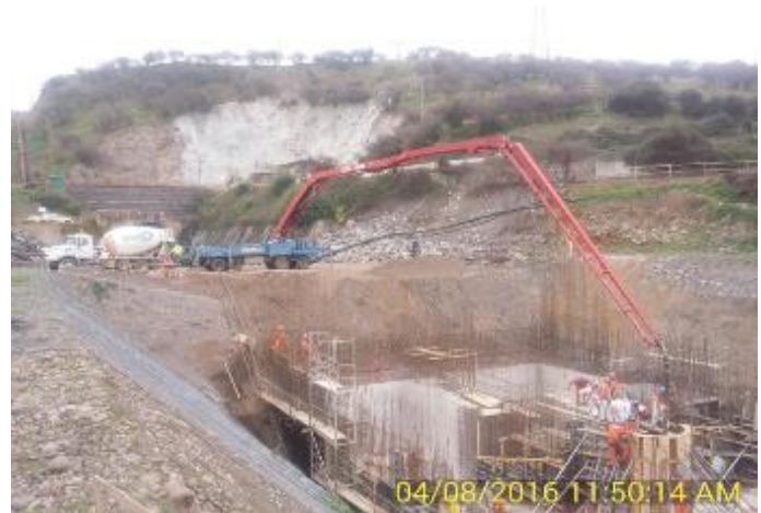
Hormigones primera parte de la 3ª Etapa de Hormigonado. Muros 9, 10 y 11. 81 m3.
