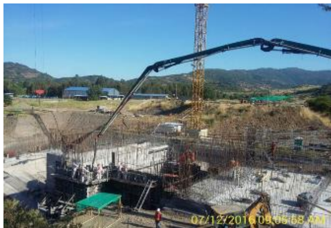
Hormigonado muros N° 23, 24, 28 y 29 Casa de Máquinas. Son 28 m 3 de H 25. 5ª Etapa de Hormigonado.
