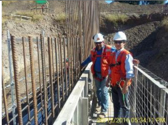
Recepción del Moldaje y la Enfierradura del Diente Canal de Descarga. Sres. Mario Sailer L. y Carlos Ramírez H. Supervisor OOC de la CHCV. 7a Etapa de Hormigonado.
