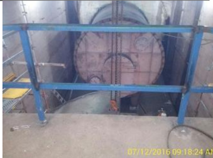
Corte y retiro por partes del resto de la Tubería de 3.800mm. Se observa la Tapa Provisoria.
