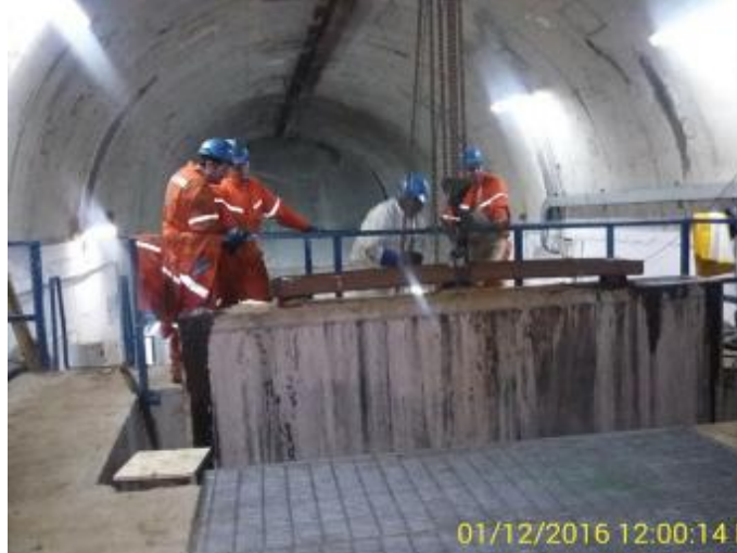
Desmontaje del Tablero de la Compuerta Bureau por la parte superior de la Cámara de Válvulas. Túnel Sur.
