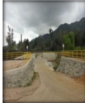
Vista panorámica Bocatoma Canal Lolol Sur.
