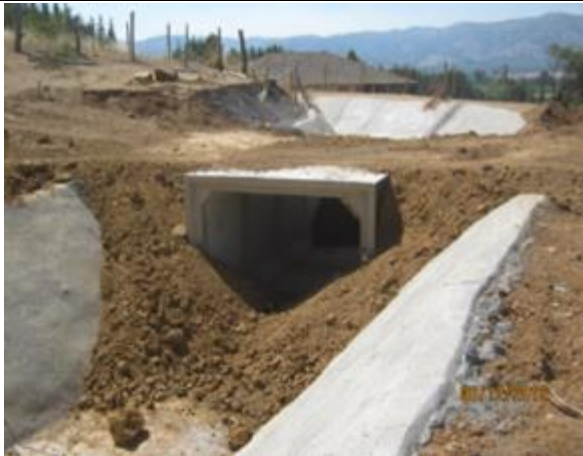
Relleno estructural, acceso a predio, Km 12,090.
