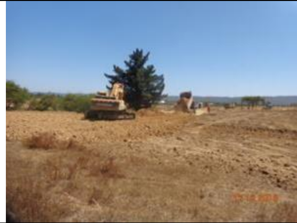
Escarpe plataforma canal, Km 47,020
