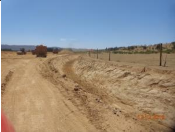
Excavación corte de Canal, Km 47,360.
