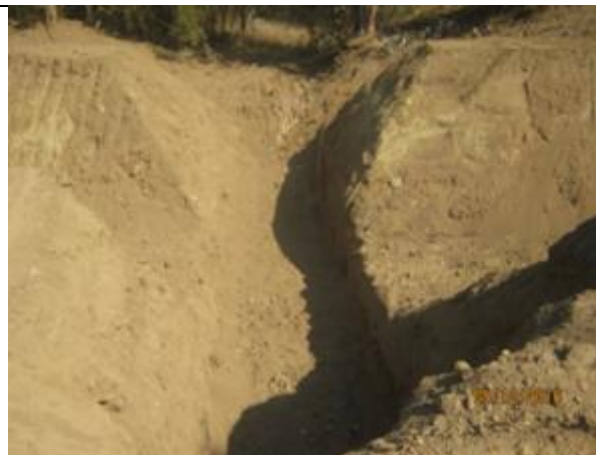
Movimientos de tierra, (Km 10,550 – Km 11,800).
