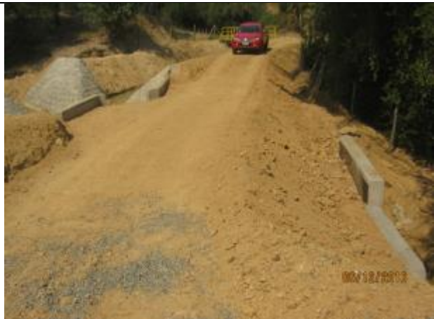
Relleno estructural tubería HDPE y mampostería muro salida, cruce de quebrada, Km 22,780
