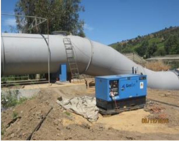
Instalación y soldadura pieza especial (cuello cisne), tubo prefabricado a estribo de entrada paso aéreo sobre Estero Nerquihue.
