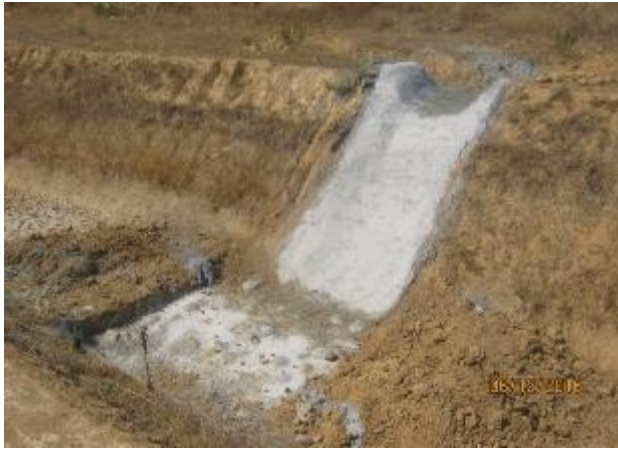
Revestimiento, descargas de quebrada (Km 22,460 – Km 22,560).
