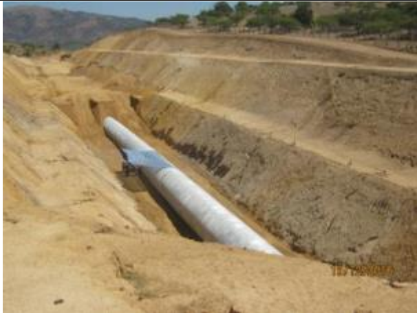
Relleno estructural e instalación tubería corrugada (Km 20,650 – Km 20,800).
