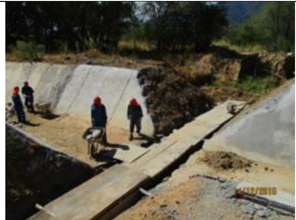
Hormigonado y moldajes en quebrada CQ7, Km 1,140.
