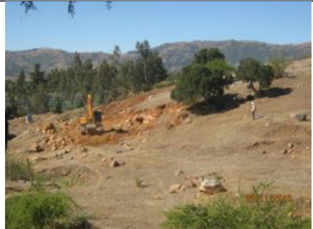
Escarpe de plataforma, sector urbano (Km 7,550 – Km 7,720).
