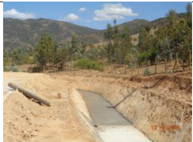
Revestimiento fondo canal, Km 11,280
