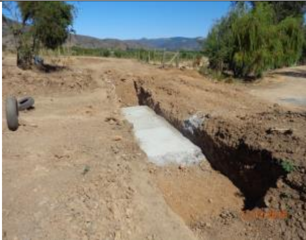
Emplantillado Paso Predial, Km 1,153.
