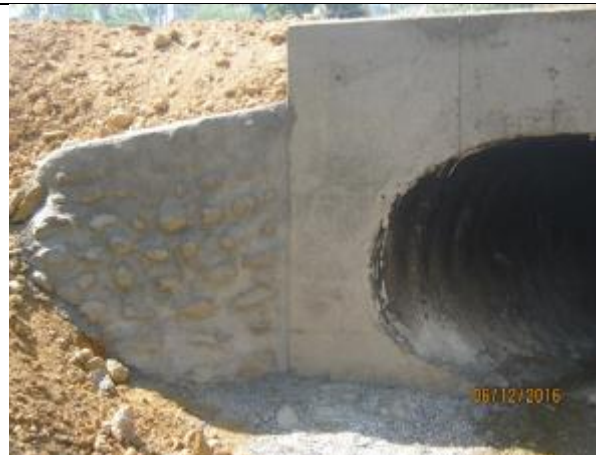
Relleno estructural tubería HDPE y mampostería muro salida, cruce de quebrada, Km 22,780
