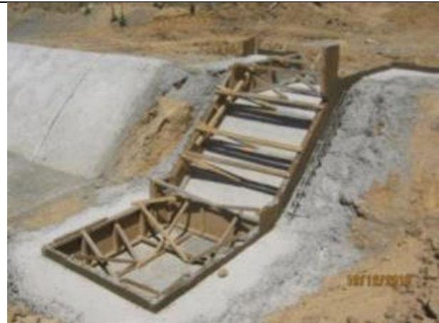
Hormigonado descarga de quebrada, Km 15,000.
