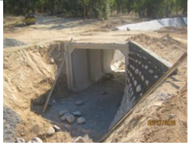
Mampostería entrada y salida, accesos a predio (Km 14,410 – Km 14,700).
