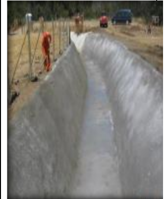
Canal revestido, (Km 1,600- Km 1,645).
