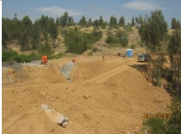
Reparación mamposterías entrada y salida en quebrada CQ7, Km 24,630.
