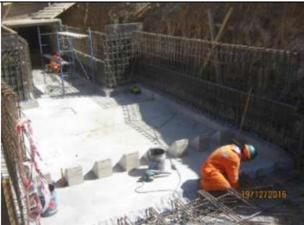
Preparación enfierradura y moldajes muros, conexión rebalse CNU con Ruta I-72.
