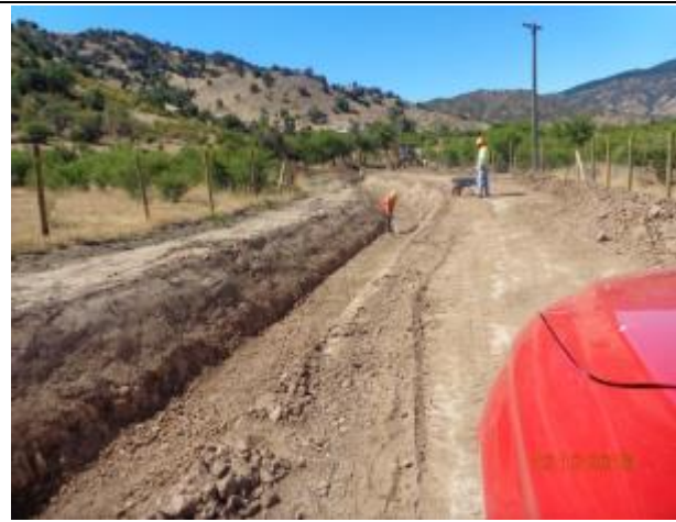
Preparación Sello fondo de Canal, Km 2,300.
