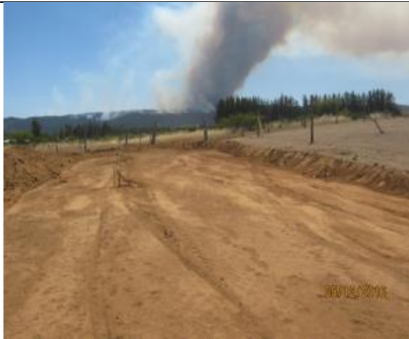
Movimientos de tierra, (Km 46,650 – Km 47,400).
