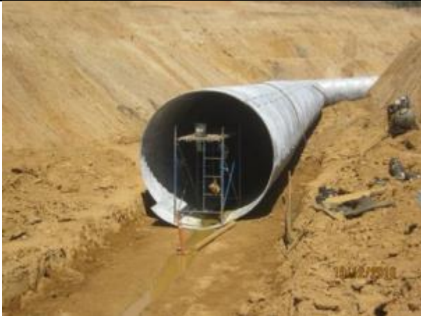
Instalación tubería corrugada, Km 20,800.
