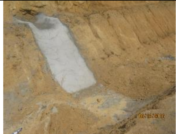
Revestimiento, descargas de quebrada (Km 22,460 – Km 22,560).
