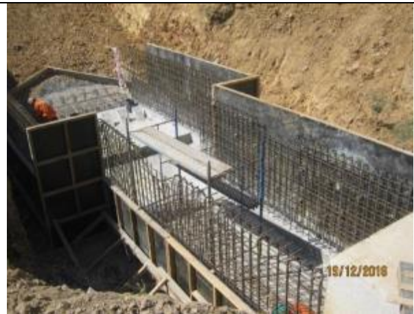
Preparación enfierradura y moldajes muros, conexión rebalse CNU con Ruta I-72.
