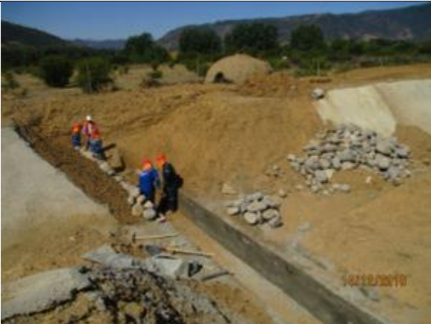
Hormigonado y mampostería en quebrada CQ7, Km 1,740.
