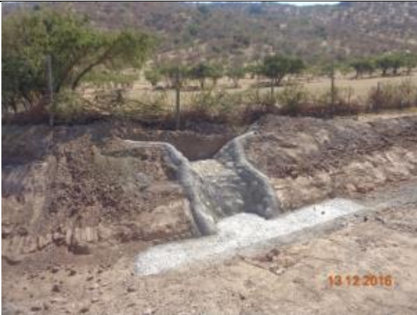
Mampostería Mini Descarga, Km 4,280.
