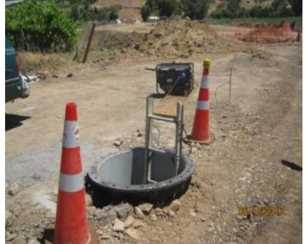
Reparación sello transición curva horizontal sifón C-3, (Km 0,450 – Km 0,480).
