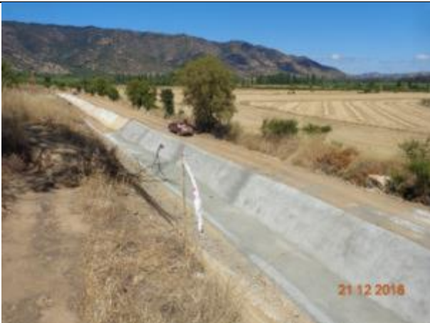
Revestimiento de Canal, Km 0,080.
