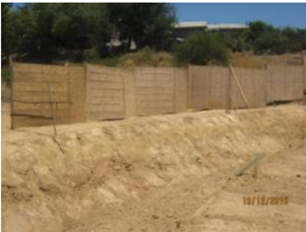
Movimientos de tierra e instalación de pantallas acústicas (Km 7,650 – Km 7,730).
