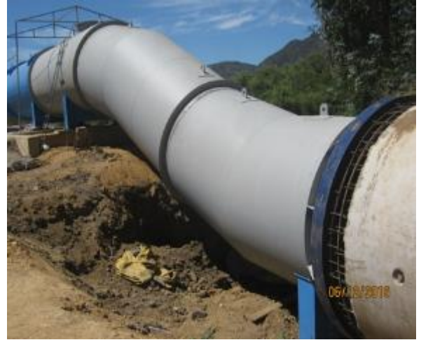
Instalación y soldadura pieza especial (cuello cisne), tubo prefabricado a estribo de entrada paso aéreo sobre Estero Nerquihue.
