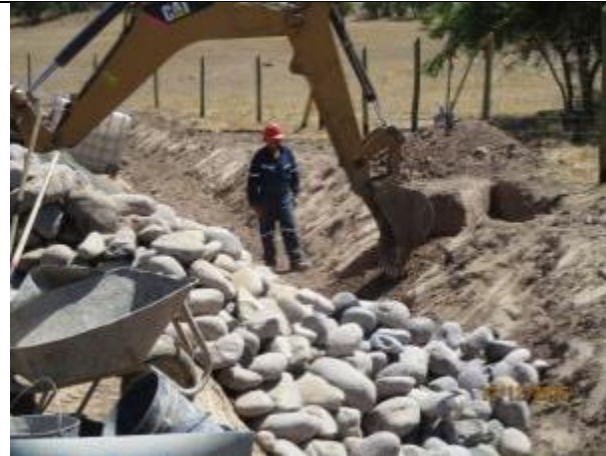
Mampostería de descarga a canal, Km 5,440.
