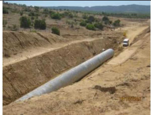
Instalación tubería corrugada, Km 20,800.
