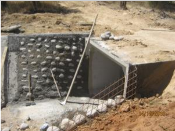
Mampostería entrada, acceso a predio, Km 14,700
