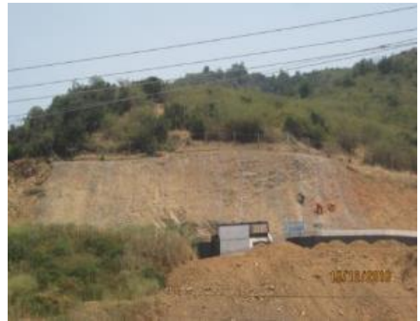
Instalación malla protección talud, Km 12,240
