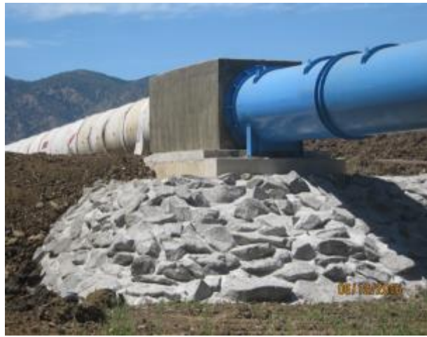
Descimbre moldajes dado unión estribo de salida paso aéreo sobre Estero Nerquihue a tubo prefabricado.
