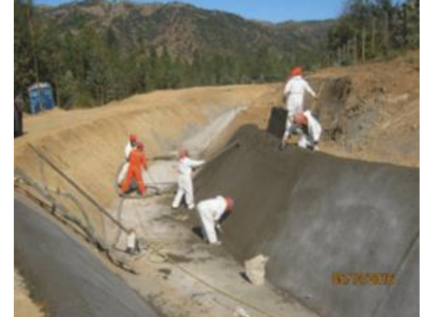
Revestimiento de Canal, Km 11,460.
