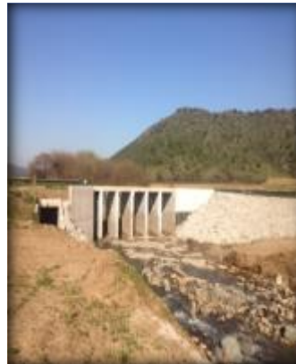
Bocatoma Canal Norte Unificado, barrera frontal.
