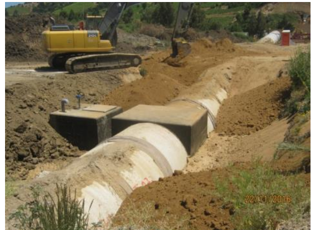
Relleno estructural, desagüe sifón N°2, Km. 0,300.
