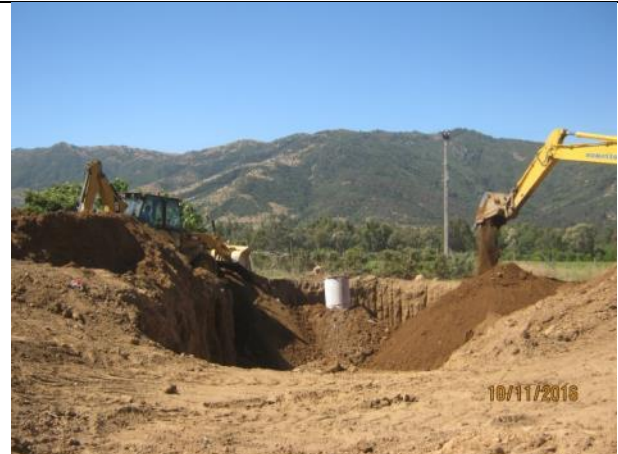
Instalación tubos prefabricados, noria costado canal, Km. 3,200.
