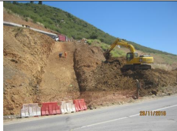
Excavación y preparación sello fundación canal superficial de rebalse.
