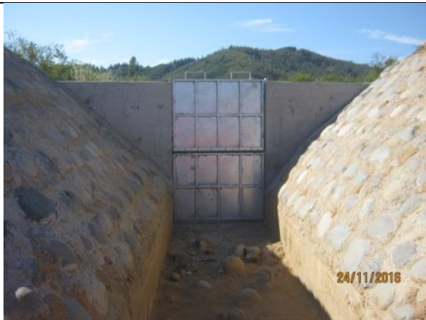
Instalación compuerta en quebrada CQ7, Km. 30,400.
