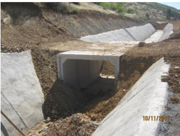
Relleno estructural, acceso a predio, Km. 3,950.
