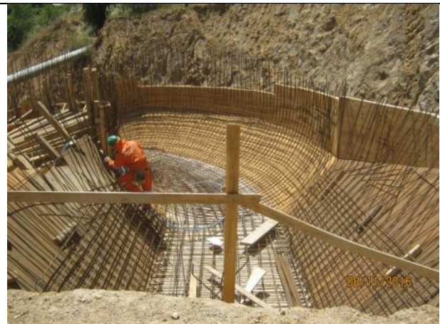
Enfierradura y moldajes, Obra de Entrega Canal Sur, (Km. 1,980 – Km. 2,000).
