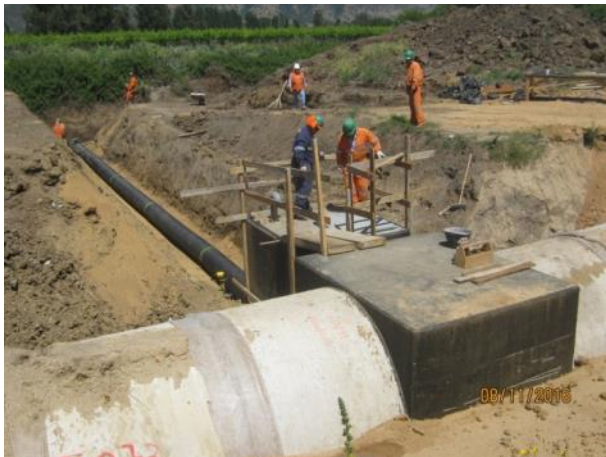
Canalización con tubería HDPE y relleno estructural, desagüe sifón N°2, Km. 0,300.
