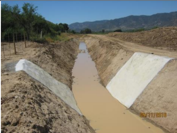
Revestimiento de taludes, quebrada Km 17,575.
