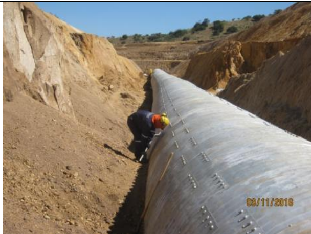
Torqueo pernos tubería corrugada, Km. 20,950.
