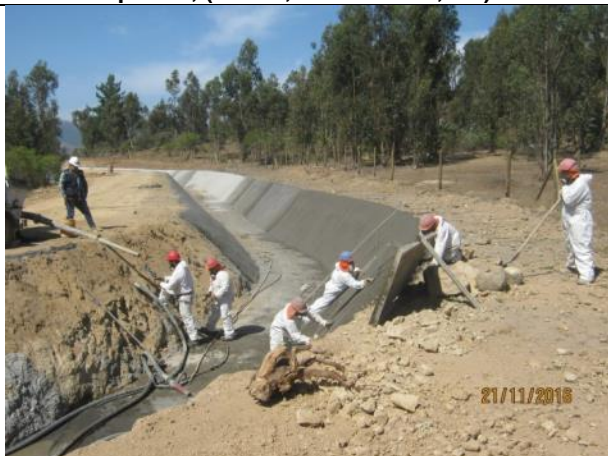
Revestimiento canal, (Km 12,700 - Km. 12,940).
