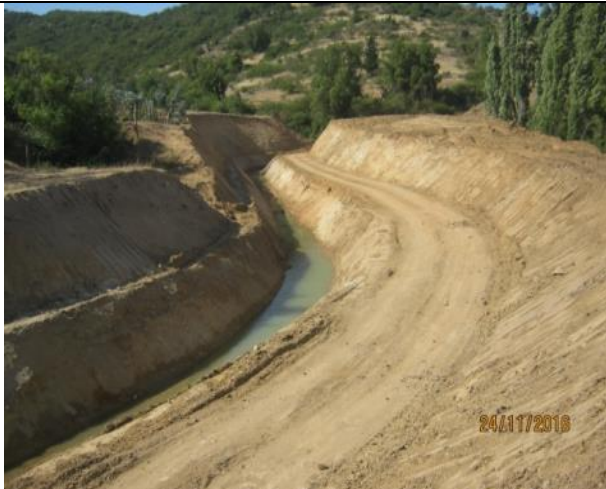
Excavación corte canal (Km 31,140 – Km. 31,800).
