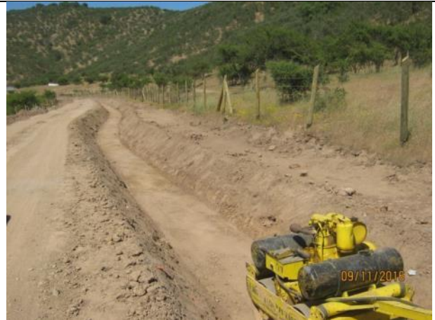
Preparación sello fondo canal, (Km. 4,300 – Km. 4,740).
