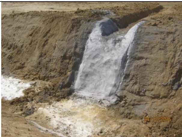
Mamposterías y revestimiento, descargas de quebrada, (Km 31,900 – Km. 35,600).
