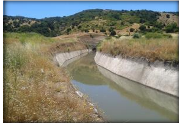
Sector de salida poniente Túnel La Lajuela.
