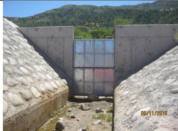
Instalación compuerta en quebrada CQ7, Km 17,790
