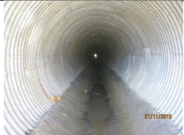
Hormigonado protección anti abrasión (fondo tubería), (Km20,900 – Km. 21,100).
