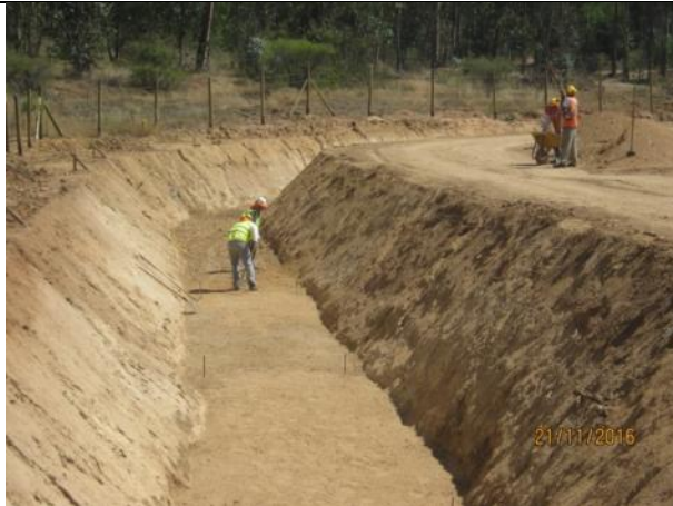
Preparación sello fondo canal,( Km 14,300 – Km. 14,400).
