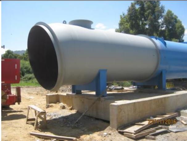
Instalación apoyo estribo de entrada y pieza especial a paso aéreo sobre Estero Nerquihue.
