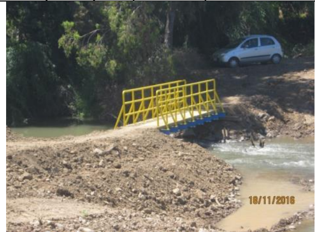
Instalación provisoria, pasarela sobre Estero Nerquihue.
