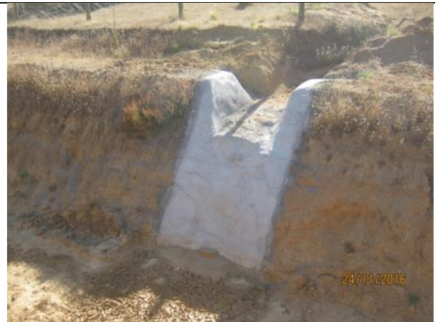
Excavaciones, mamposterías y revestimiento, descargas de quebrada (Km 30,320 – Km. 31,460).
