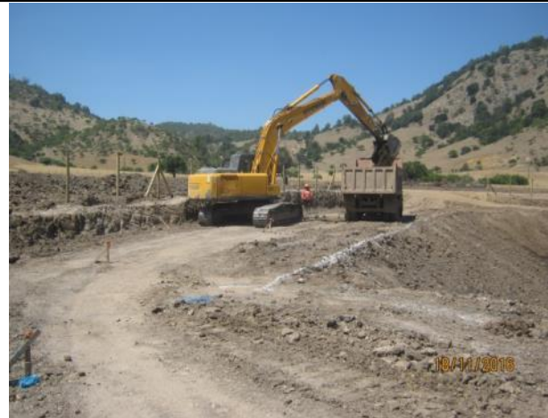
Movimiento de tierras, (Km 0,180 – Km. 0,700).
