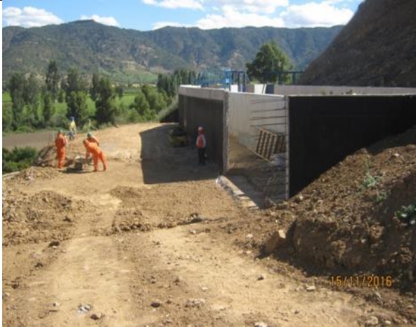
Relleno estructural, obra de entrega a Sifón Nerquihue, (Km 12,200 – Km. 12,230).
