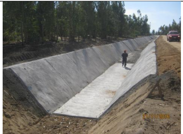
Revestimiento canal, (Km 11,800 – Km. 12,660).
