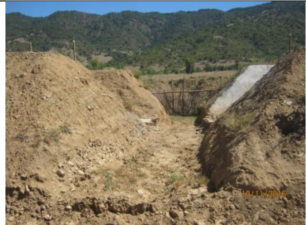
Excavación en quebrada CQ7, Km. 1,740.
