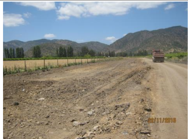
Movimientos de tierra, (Km. 0,480 – Km. 0,820)
