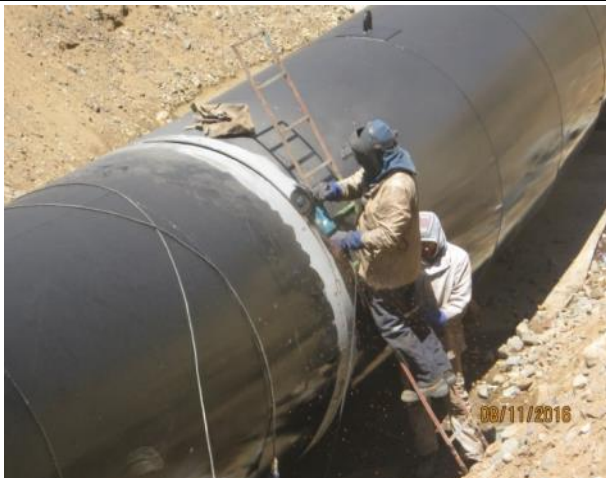
Soldadura, curva horizontal sifón C-6, (Km. 1,350 – Km. 1,390).
