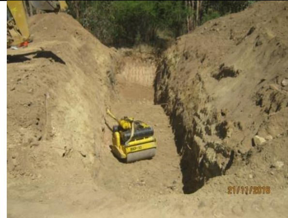
Excavación de corte en terreno natural, quebrada Km. 14,710.
