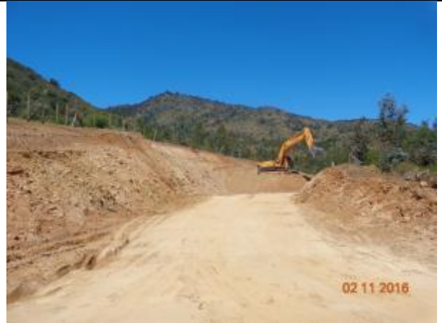
Movimiento de tierras, (Km 10,550 – Km. 11,800).
