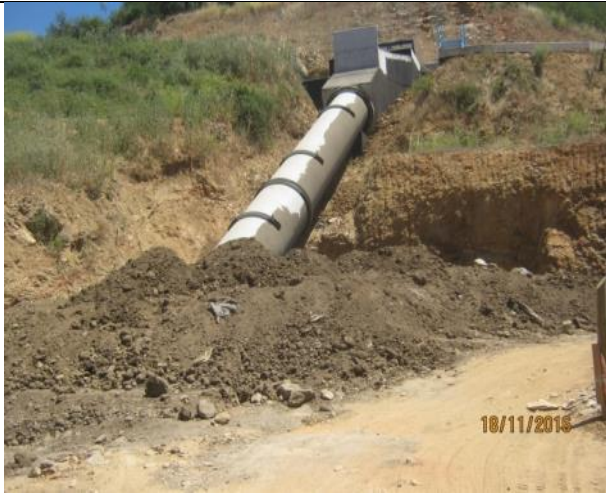
Relleno estructural, tubería acero obra de descarga, cruce Ruta I-72.
