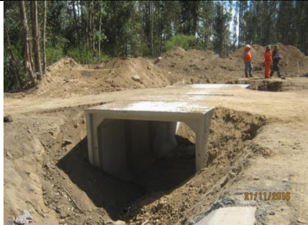
Relleno estructural, accesos a predio, (Km 14,410 – Km. 14,700).
