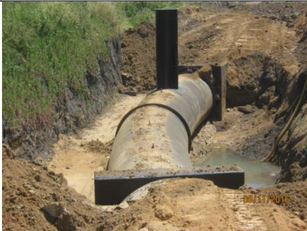
Hormigonado unión acero/hormigón, soldadura ventilación y relleno estructural curva horizontal sifón C-4, (Km. 0,780 – Km. 0,800).
