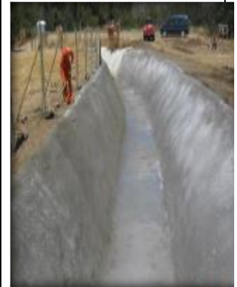
Canal revestido, (Km. 1,600- Km 1,645).
