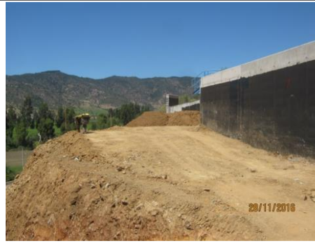
Relleno estructural, obra de entrega a Sifón Nerquihue, (Km 12,200 – Km. 12,230).
