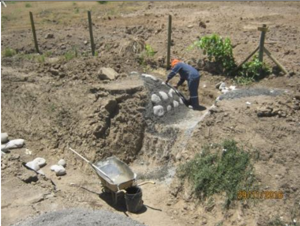
Excavación y mamposterías, descargas de quebrada, (Km. 1,760 – Km. 2,560).
