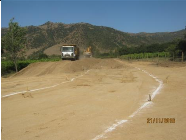
Movimiento de tierras, (Km. 10,550 – Km. 11,800).
