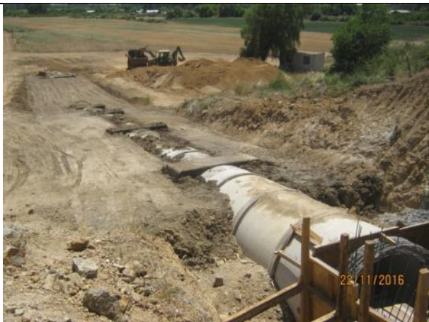
Relleno estructural, tubería prefabricada (Km. 1,960 – Km. 1,980).
