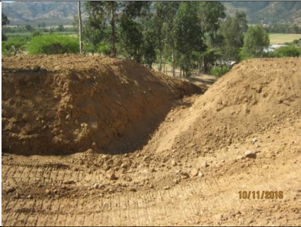
Excavación en quebrada CQ7, Km. 4,300.
