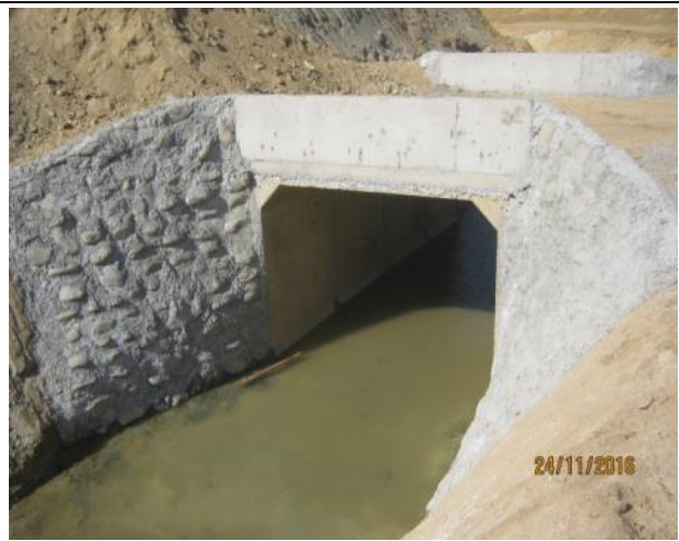
Mamposterías entrada y salida, acceso a predio (Km. 31,520).
