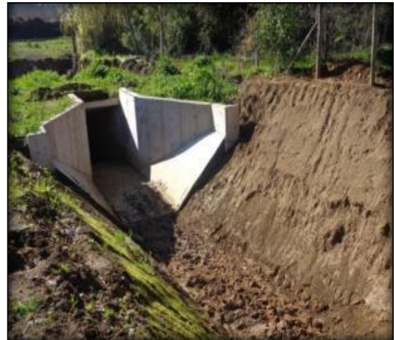
Cámara de salida de Sifón Fortaleza.
