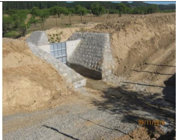
Hormigonado muros y badén e instalación compuerta en quebrada CQ7, Km. 42,725.
