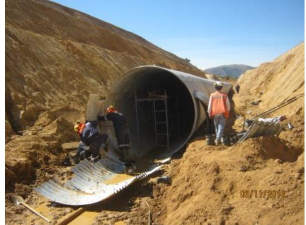
Instalación tubería corrugada, Km. 20,800.
