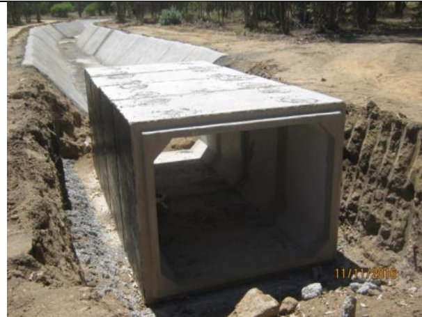
Instalación de cajones, accesos a predio, (Km. 14,415 – Km. 14,700).
