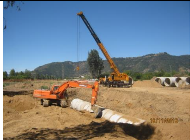
Instalación tubería prefabricada y relleno estructural, (Km. 1,280 – Km. 1,350).
