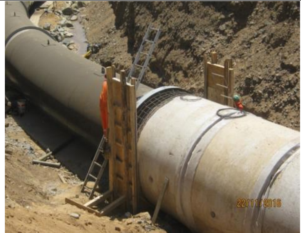
Preparación de moldajes unión acero/hormigón, curva horizontal sifón C-6, (Km. 1,350 – Km. 1,390).
