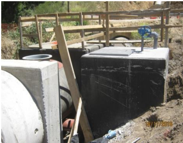
Instalación ventilación y tapa de cámara desagüe N°1, Km. 0,060.
