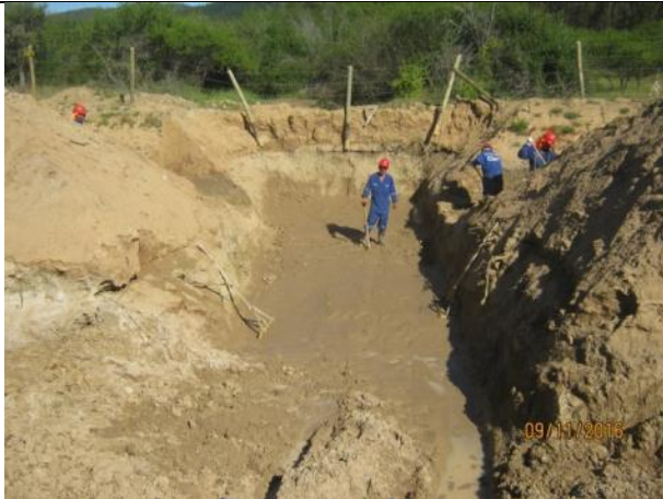
Movimiento de tierras en quebrada CQ7, Km. 44,470.
