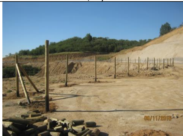
Instalación de cercos (Km. 37,200 – Km. 37,680).
