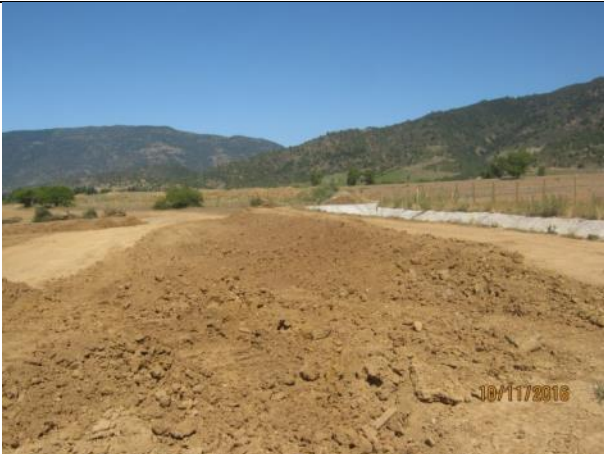
Movimiento de tierras, (Km 2,300 – Km. 2,450).
