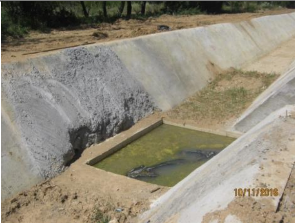
Hormigonado descarga de quebrada, Km. 0,990
