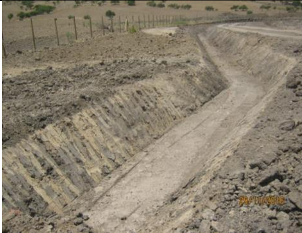
Excavación de corte en terreno natural (Km 0,020 – Km. 0,150).
