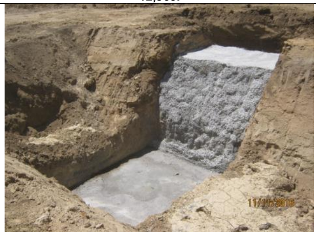
Excavación y emplantillado, descarga de quebrada, Km. 14,200.
