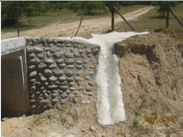
Revestimiento descarga saneamiento, acceso a predio, Km 17,900
