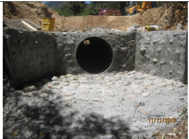
Muro de boca salida tubería HDPE, quebrada Km. 12,960.
