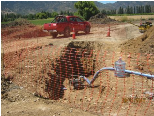
Reparación sello transición curva horizontal sifón C-3, (Km. 0,450 – Km. 0,480).
