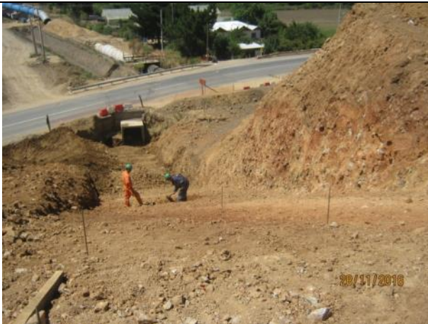
Excavación y preparación sello fundación canal superficial de rebalse.
