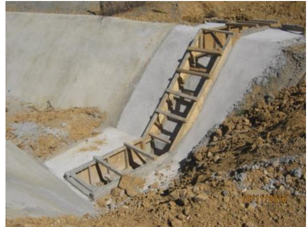
Hormigonado, descarga de quebrada, Km. 4,180.
