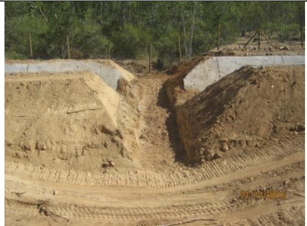
Excavación en quebrada CQ7, Km. 12,105.
