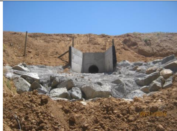
Reparación enrocado consolidado, descarga de quebrada, Km. 19,750.
