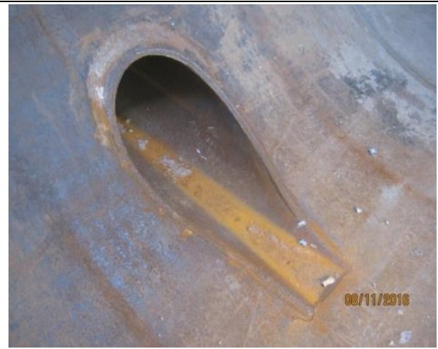
Soldadura insertos desagüe N°1, Km. 0,060
