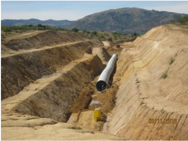
Instalación tubería corrugada, Km. 20,800.
