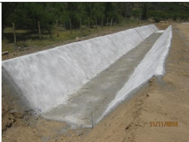
Revestimiento canal, (Km 13,000 - Km. 13,160).
