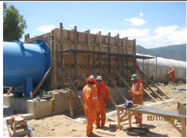
Preparación moldajes en estribo de salida, unión paso aéreo sobre Estero Nerquihue a tubo prefabricado
