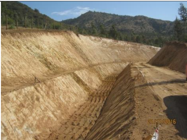
Movimiento de tierras, (Km 10,550 – Km. 11,800).
