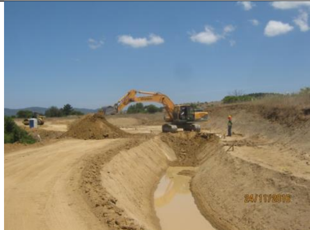
Movimiento de tierras, (Km 46,500 – Km. 47,300).
