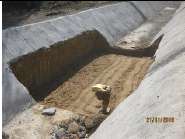
Excavación y preparación sello fundación, accesos a predio, (Km 11,960 - Km. 12,090).
