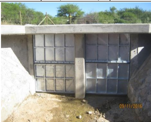
Instalación compuertas en quebrada CQ7, Km. 41,270.
