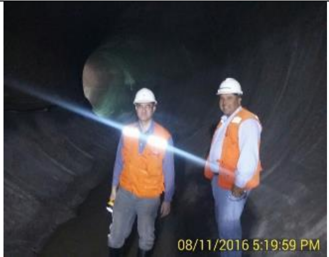
El Sr. Marcelo Beratto R. IFE del MOP y los Sres. Rene Valenzuela Ch. de la CHCV y Douglas Greig P. de ICESA, recorren el Túnel Sur hasta el Tapón Toriesférico. Posteriormente revisan la Casa de Máquinas.
