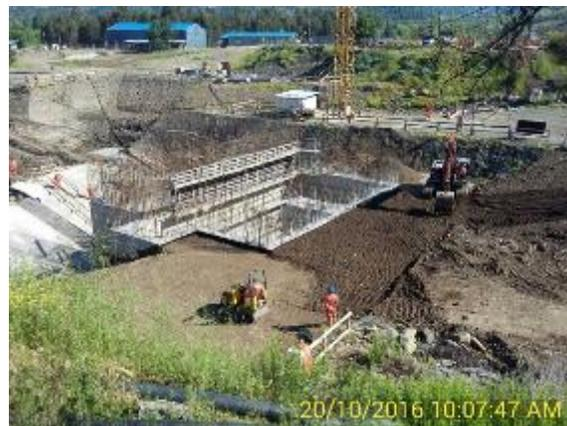
**Relleno Compactado lado Sur y Oriente de la Casa de Máquinas de la Central Hidroeléctrica Convento Viejo.**
