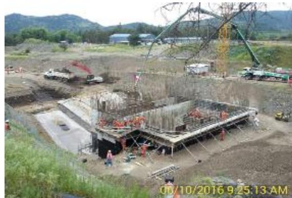
Hormigonado de los Muros N° 12, 13, 14, 15, 17, 18 y lo que resta del 19. 61 m3 de H25. Con esto se termina la 4ª Etapa de Hormigonado de la Casa de Máquinas.
