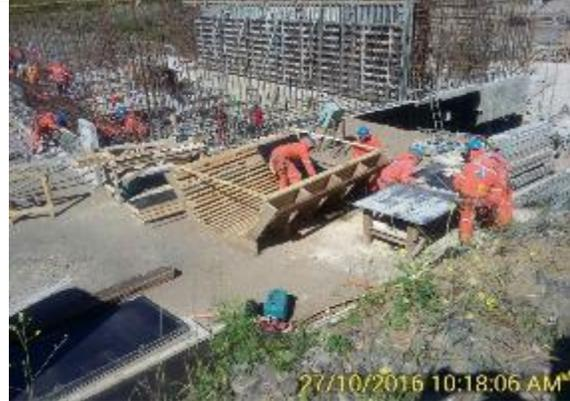
Fabricación del Moldaje de la punta del Muro 30. En la parte superior se aprecia la enfierradura de la Losa de Fundación del Muro 27, para el Radier de los Tubos de Aducción y Válvulas Mariposa de la Central Hidroeléctrica.
