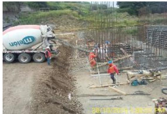
Hormigonado Fundación del Tubo Curvo de la Aducción. 20 m3 de H25.
