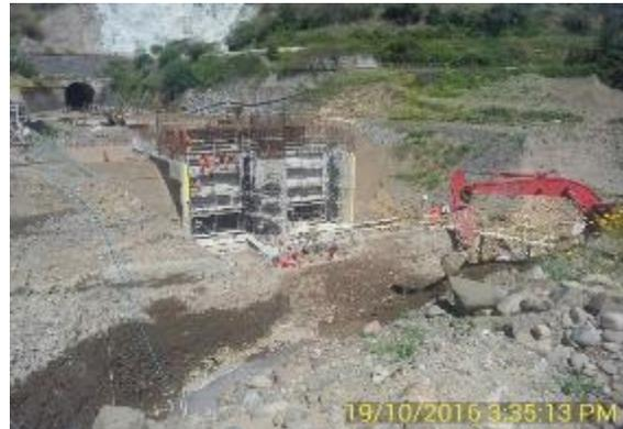
**Término de la Excavación del Diente de Anclaje del Canal de Descarga de la Central Hidroeléctrica Convento Viejo.**
