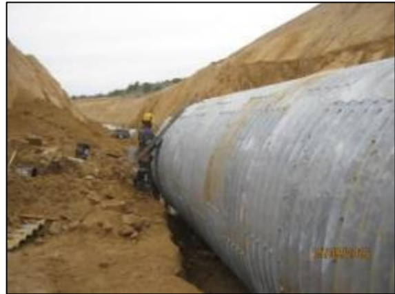
Instalación tubería corrugada, relleno estructural, torqueo pernos y preparación cama apoyo (Km 20,850 – Km 20,900).
