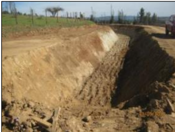
Excavación corte canal Km 13,000 – Km 13,280.
