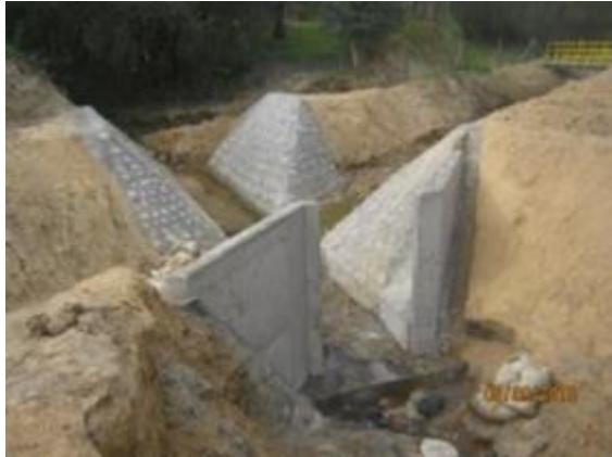
Hormigonado muros compuerta CQ7, Km 22,780.
