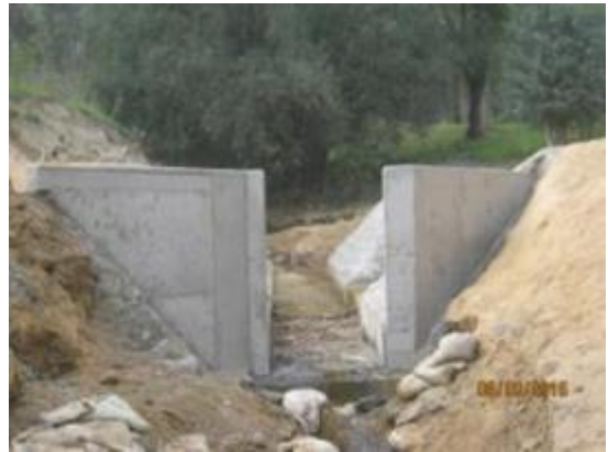
Hormigonado muros compuerta CQ7, Km 22,780.
