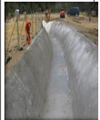
Canal revestido, (Km 1,600- Km 1,645).
