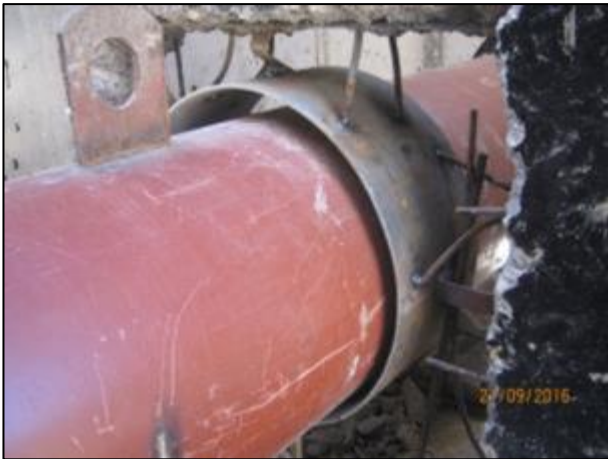
Trabajos insertos desagüe N°1, Km 0,060.
