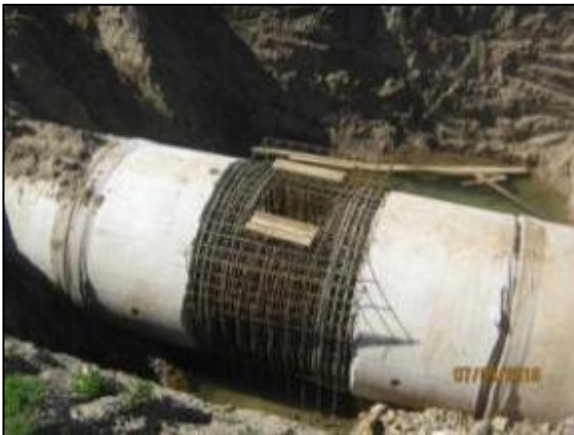
Enfierradura uniones tubos prefabricados, ventosa N°4, Km 1,100.
