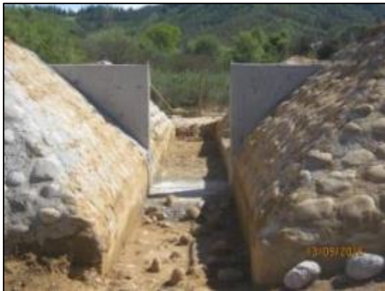
Hormigón muros compuerta CQ7, Km 30,400.
