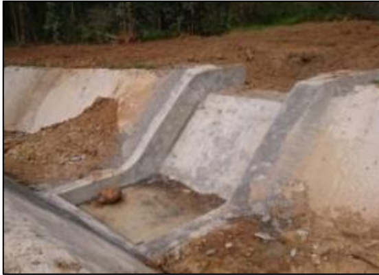
Hormigonado descarga de quebrada, Km 2,680.
