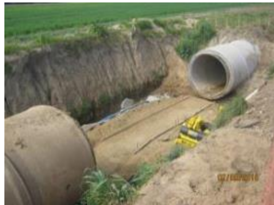
Preparación sello fundación, curva horizontal sifón C-7, Km 1,740.
