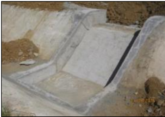
Hormigonado descarga de quebrada, Km 2,995.
