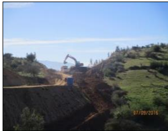
Excavación corte plataforma de canal, Km 32,440
