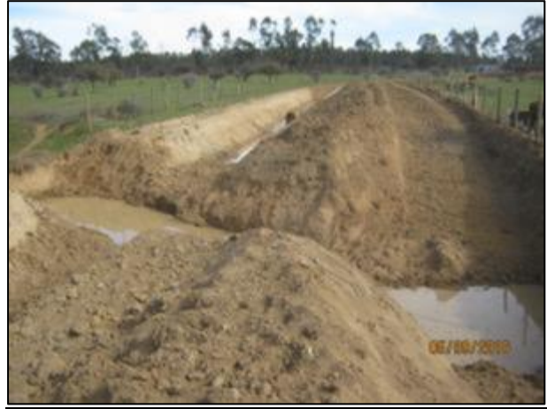
Excavación CQ7, Km 45,120.
