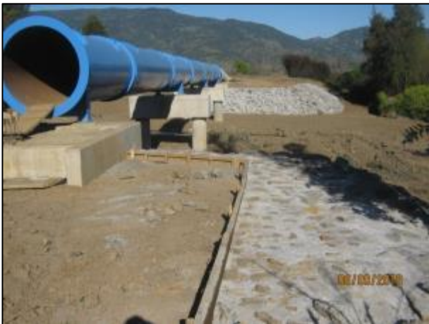
Enrocado consolidado, estribo de entrada paso aéreo sifón sobre Estero Nerquihue.
