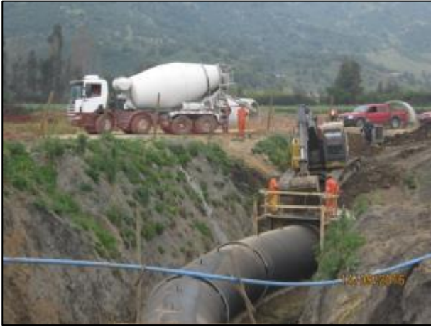
Hormigonado unión acero/hormigón, curva horizontal sifón C-5 (Km 0,870 – Km 0,900).
