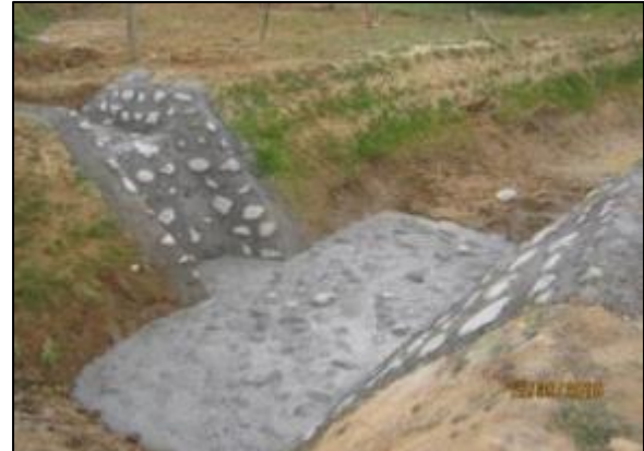
Hormigonado mini descargas de quebradas (Km 39,000 – Km 39,500).
