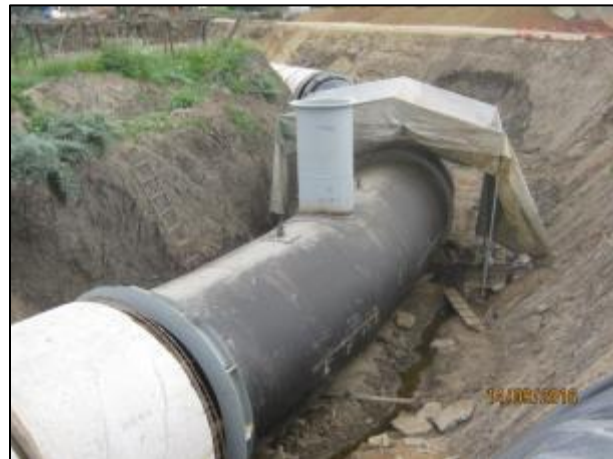
Soldadura curva horizontal sifón C-3 (Km 0,450 – Km 0,480).
