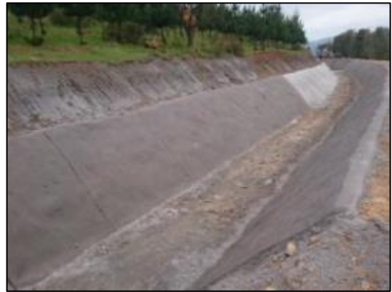
Revestimiento de canal Km 3,600 – Km 3,800.
