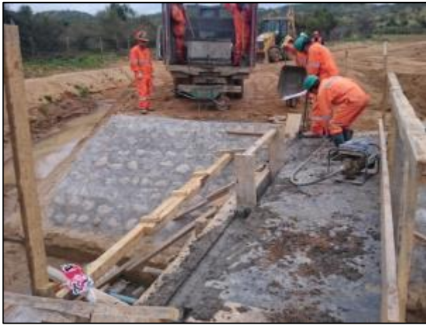
Moldajes y hormigonado muros compuerta CQ7, Km 38,840.
