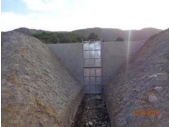
Compuertas CQ-7, Km 9,825.
