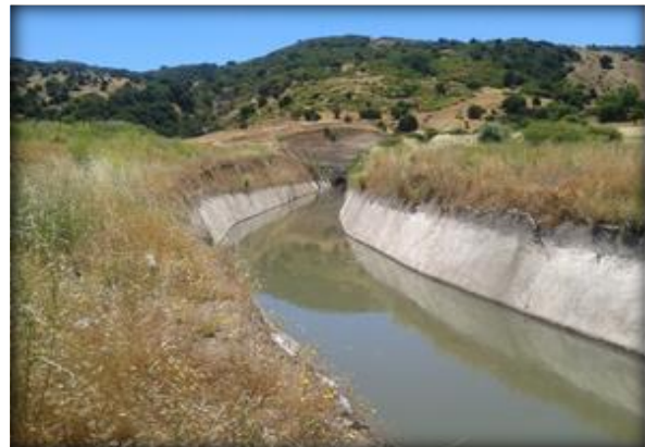
Sector de salida poniente Túnel La Lajuela.
