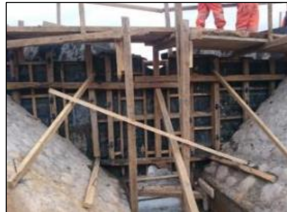
Moldajes y hormigonado muros compuerta CQ7, Km 35,100.
