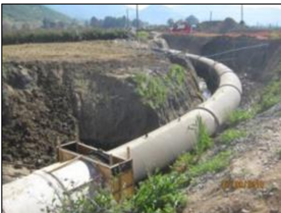
Moldajes unión acero/hormigón, curva horizontal sifón C-5 (Km 0,870 – Km 0,900).
