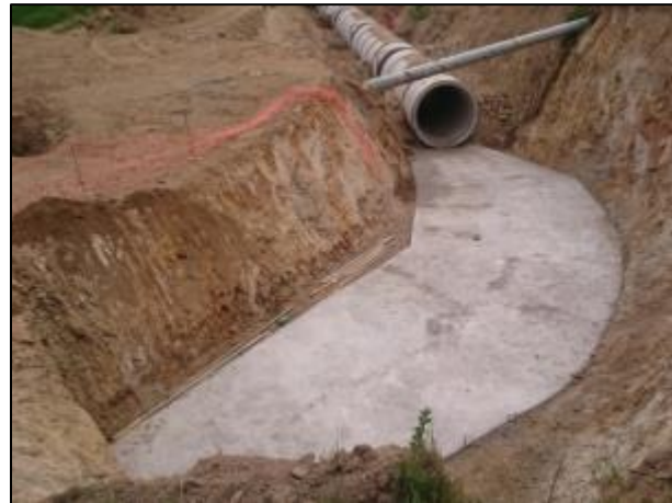
Emplantillado Obra de Entrega Canal Sur (Km 1,980 – Km 2,000).
