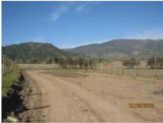
Preparación de plataforma y colocación cercos (Km 2,170 – Km 2,950).
