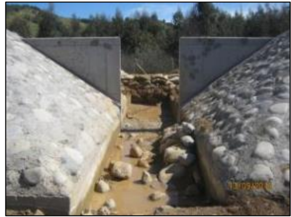
Hormigón muros compuerta CQ7, Km 28,485
