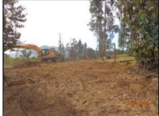
Excavación de Escarpe, Km 12,620.
