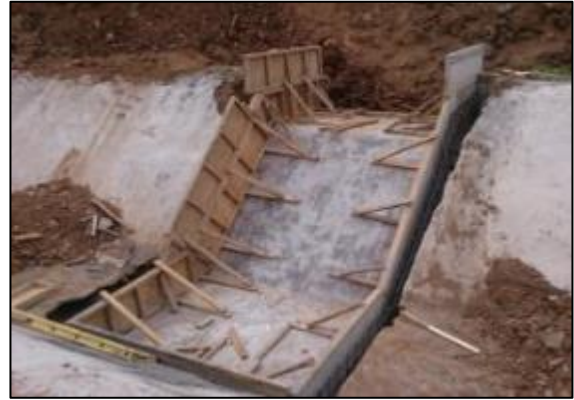
Enfierradura y moldajes descarga de quebrada, Km 2,995.
