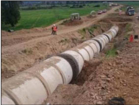
Preparación juntas hormigón/hormigón y enfierradura (Km 1,960 – Km 1,980).
