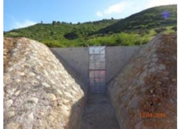
Compuertas CQ-7, Km 11,407.
