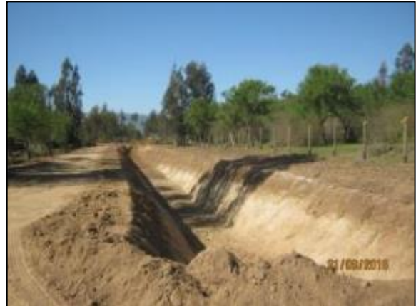
Excavación corte canal Km 12,150 – Km 13,000).
