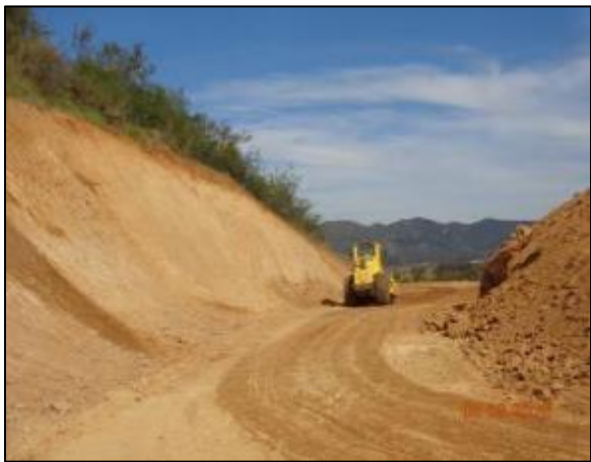
Excavación corte plataforma, Km 32,080.
