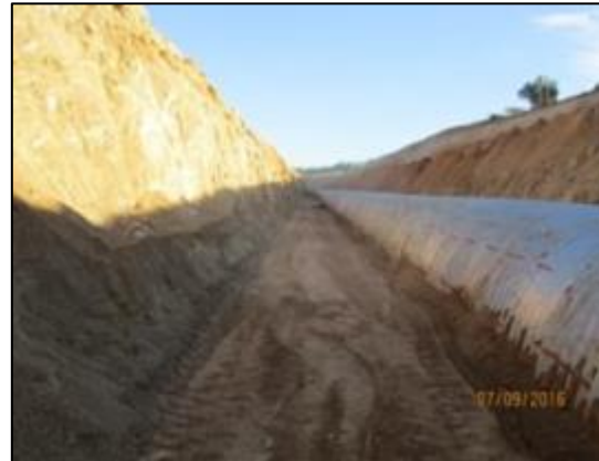
Compactacion de relleno capa 7 Lado izquierdo, Km 21,000
