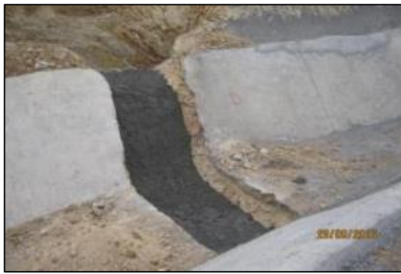
Emplantillado, descarga de quebrada, Km 3,870.
