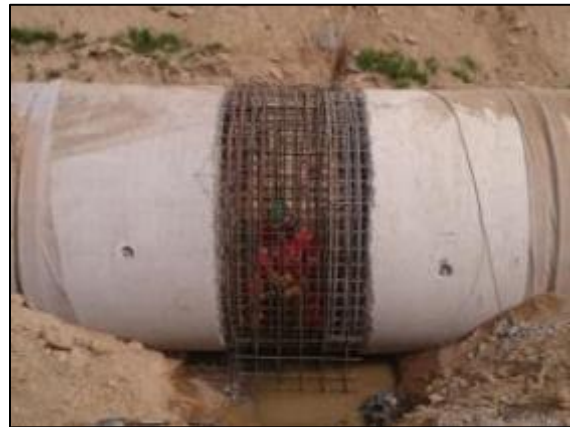
Preparación juntas hormigón/hormigón y enfierradura (Km 1,960 – Km 1,980).
