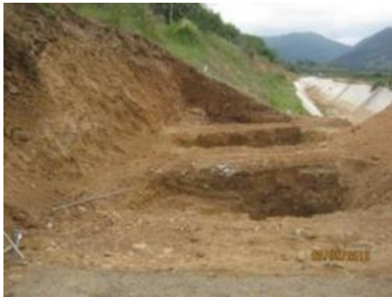
Reparación falla por deslizamiento de terreno, Km 11,760.
