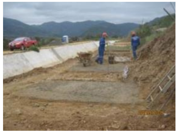
Reparación falla por deslizamiento de terreno, Km 11,760.
