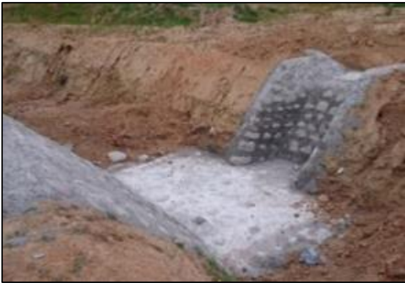
Hormigonado mini descargas de quebradas (Km 35,945 – Km 38,640).
