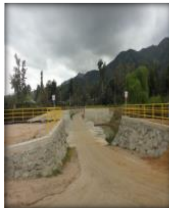
Vista panorámica Bocatoma Canal Lolol Sur.
