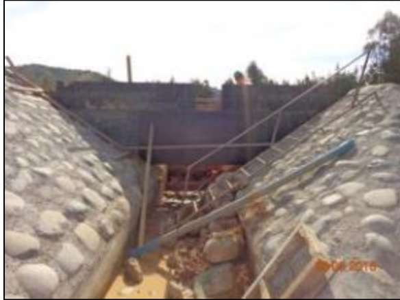
Moldaje muros compuerta CQ-7, Km 28,485
