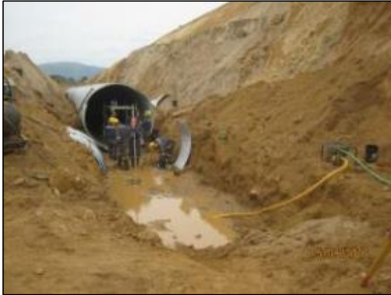
Instalación tubería corrugada, relleno estructural, torqueo pernos y preparación cama apoyo (Km 20,850 – Km 20,900).
