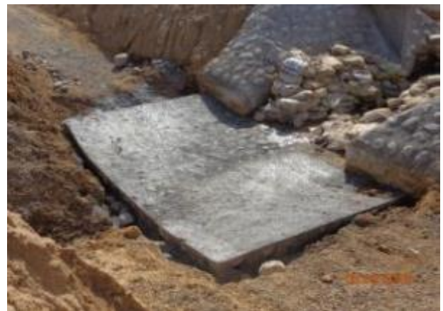
Mampostería Badén CQ-7, Km 26,555.
