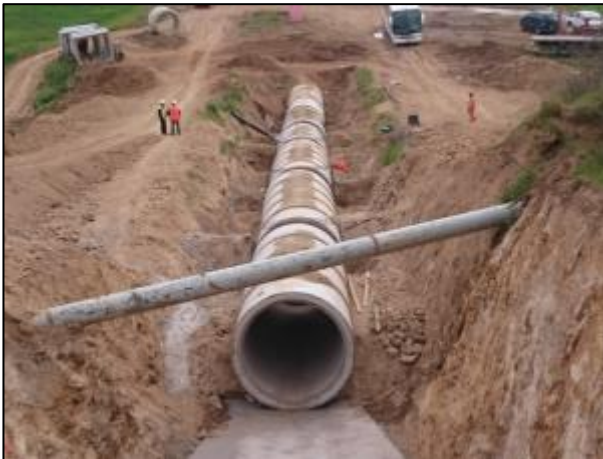
Emplantillado Obra de Entrega Canal Sur (Km 1,980 – Km 2,000).
