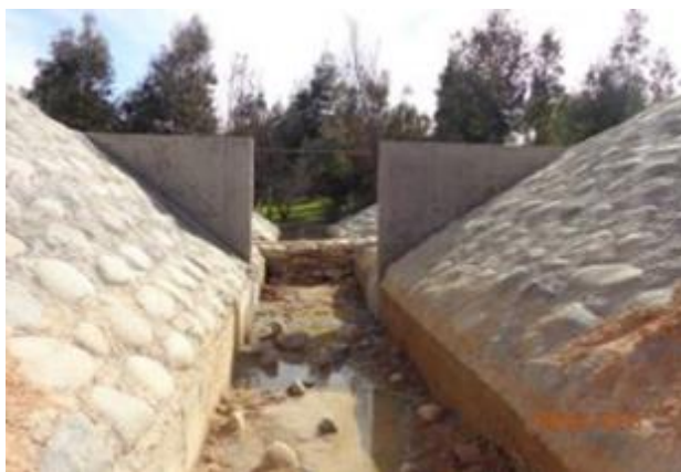
Hormigón muros compuerta CQ-7, Km 27,902
