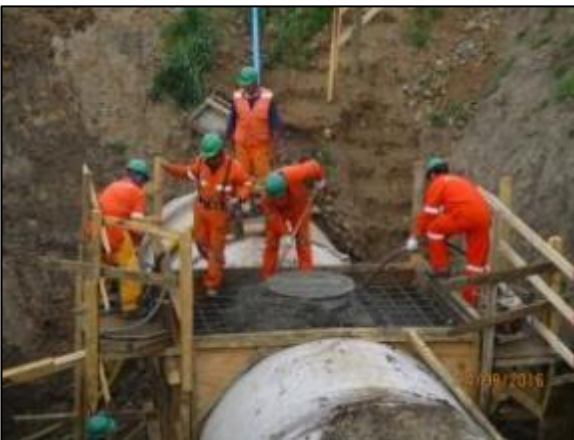
Hormigonado unión tubos prefabricados, ventosa N°4, Km 1,100.
