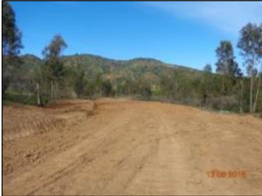
Excavación de Corte en T.C.N., Km 12,700.
