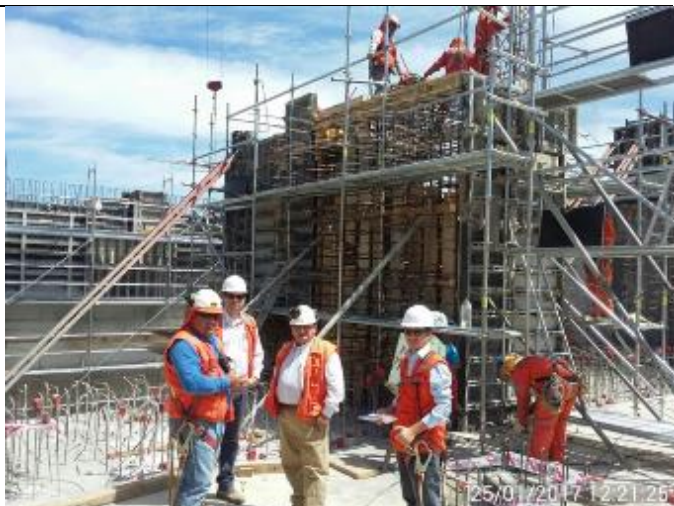
Recepción del Moldaje, Insertos y la Enfierradura del muro 22 de la Casa de Máquinas con los Sres. Mario Sailer y Pablo Díaz de la SC. Jorge González y Carlos Ramírez de la CHCV y el Sr. Douglas Greig P. Inspector Jefe y Revisor de la Central.
