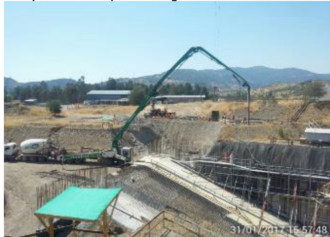
Hormigonado del muro norte del Canal de Descarga, 7ª Etapa de Hormigonado. Son 49 m 3 de H30.
