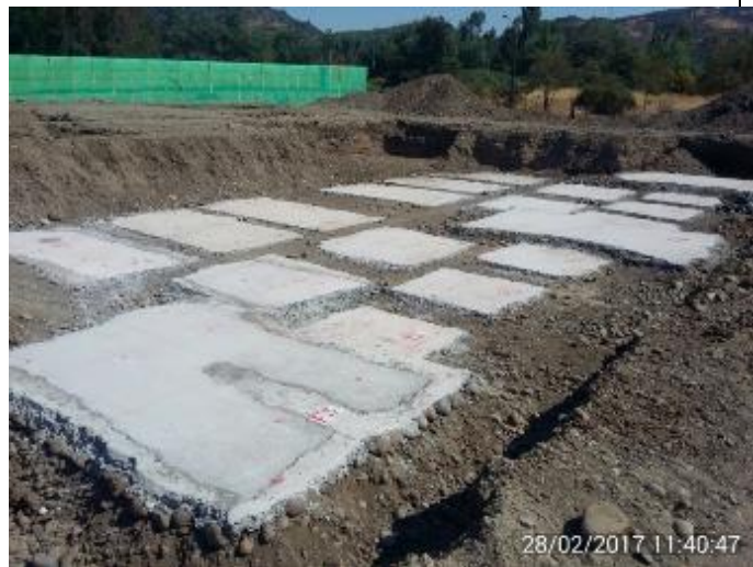
Emplantillado fundaciones SSEE tipo F1 a la F6 con H10.
