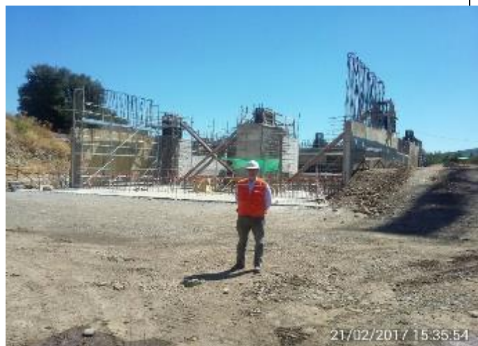
El Sr. Marcelo Beratto R. IFE del MOP, recorre la Casa de Máquinas, visita el Túnel Sur y la SSEE Eléctrica.
