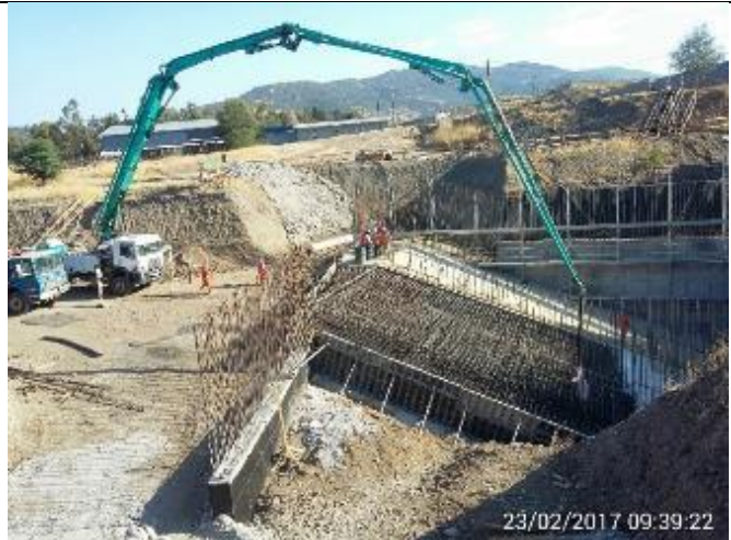
Hormigonado 2ª parte Lado Sur del Canal de Descarga de la Casa de Máquinas. Son 155 m3 de H30.
