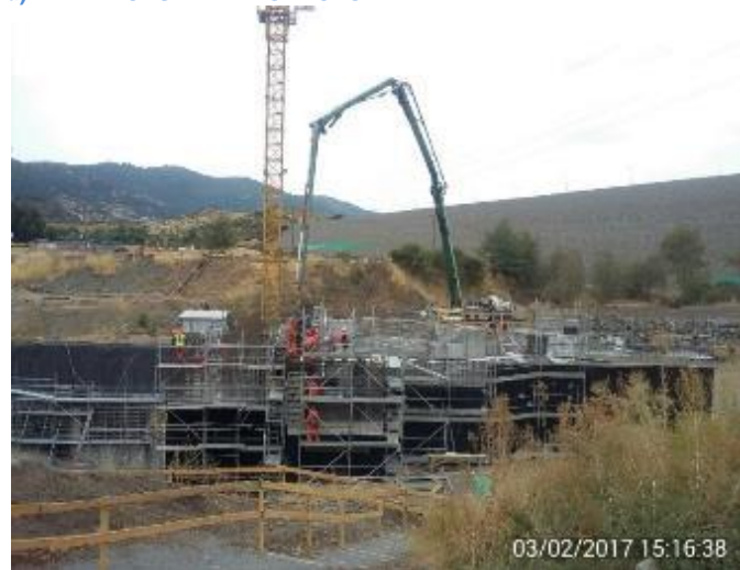
Hormigonado Muro 29 Casa de Máquinas. 5ª Etapa de Hormigonado.
