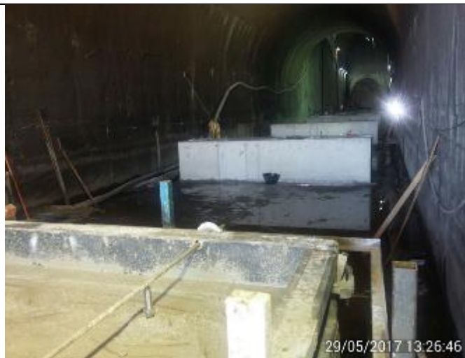
Vista General de las Fundaciones F8 a F11 de la Tubería en Presión de 3800 mm. en el Túnel Sur. Hormigonado de la F8.
