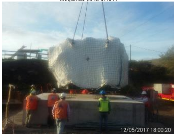
Montaje del Transformador de 20 KVA de la Casa de Máquinas de la Central Hidroeléctrica Convento Viejo.
