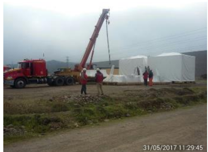
Llegada y descarga de las 2 Válvulas tipo Mariposa con sus Bridas, de las turbinas U1 y U2 de la Casa de Máquinas
