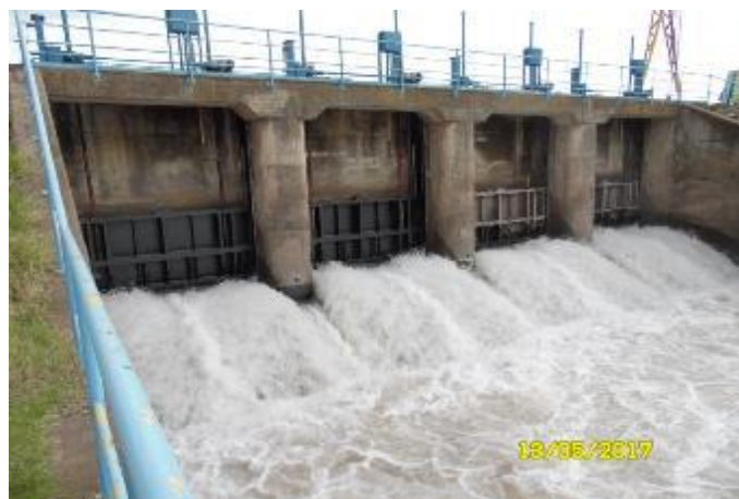
Bocatoma Canal Teno-Chimbarongo
