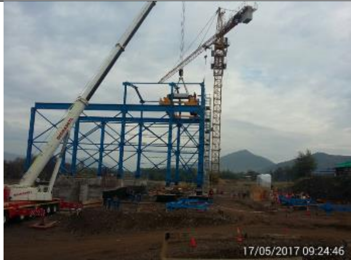
Montaje del Polipasto del Puente Grúa Konecranes 80/10 Ton, de la Casa de Máquinas de la Central Hidroeléctrica.
