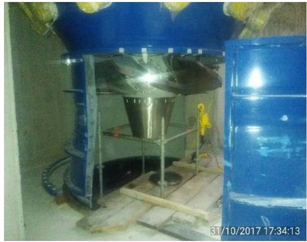
Destape de turbina para chequeo de medidas e Inspección de Álabes.
