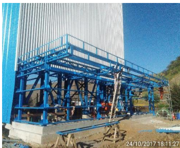
24/10/2017 18:11:27 Remates de montaje y Touch up de estructuras de oficinas Casa de Máquinas.
