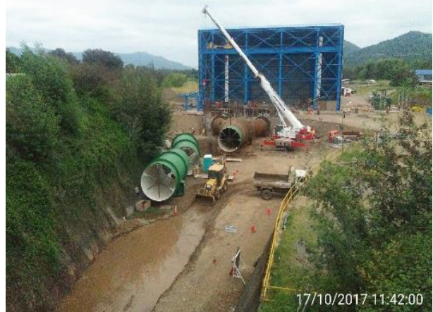
Vista General y despeje de losa para la construcción de las Fundaciones 3, 4, 5 y 6 de la Tubería en Presión.
