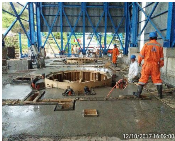
12/10/2017 16:02:00 Terminaciones de hormigón cota 243,00, Sala de Máquinas.
