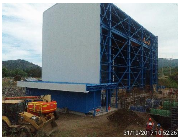
Vista general de la Casa de Máquinas al 31 de octubre de 2017.
