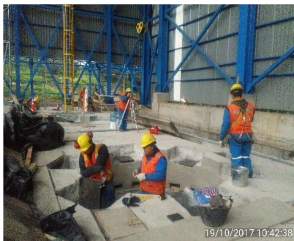
19/10/2017 10:42:38 Preparación de anclajes de Generadores en Casa de Máquinas.
