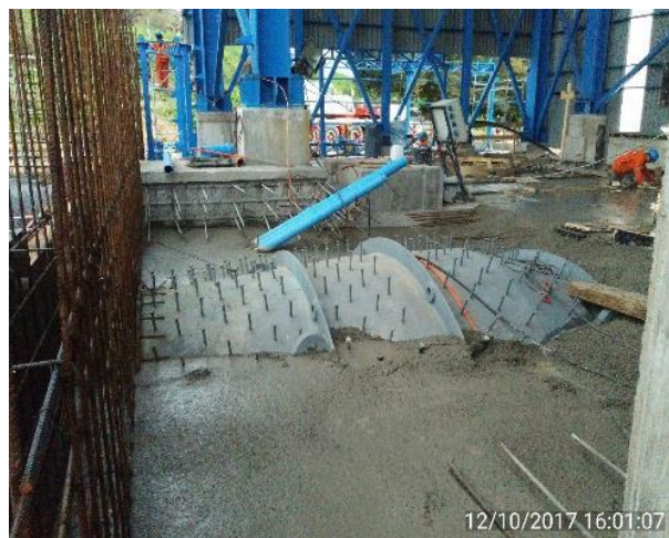
Hormigonado Codos a cota 243,00, Sala de Máquinas.
