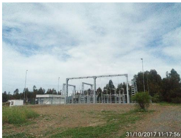
Vista general Subestación al 31 de octubre de 2017.
