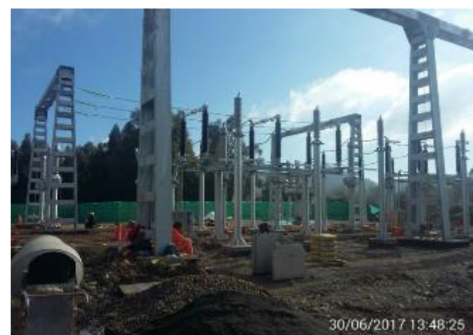
Estado de avance de la S/E de la Central Hidroeléctrica.
