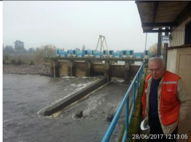
Inspección de los cables de las Compuertas del río Teno, Aducción del Canal Teno-Chimbarongo. En primer plano el Sr Eugenio Campos, Encargado de Operaciones y Conservación de la IF.
