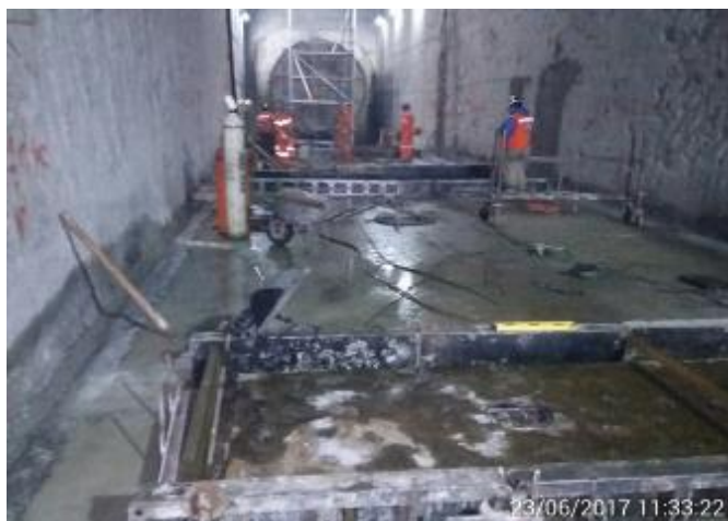
Recepción de la enfieradura, placas de insertos y el moldaje de las Fundaciones F12, F13 y F14 de la Tubería en Presión.
