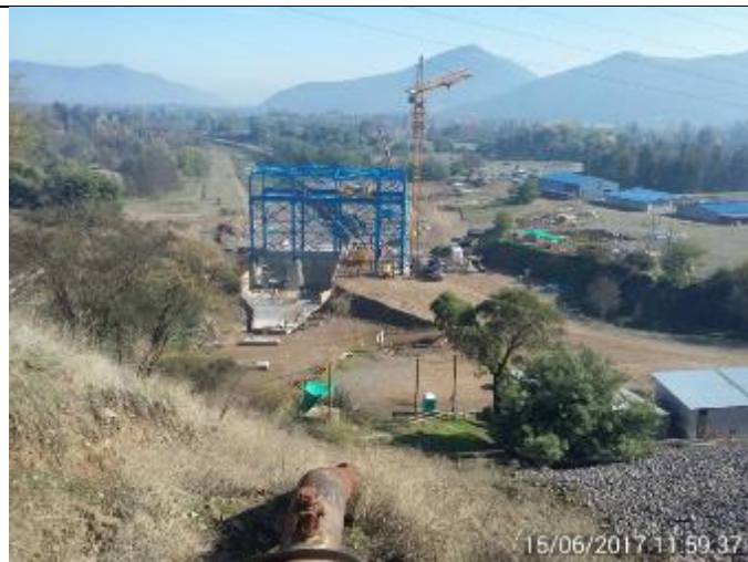
Vista panorámica del avance de la Superestructura de la Casa de Máquinas y la Losa de la Bifurcación.
