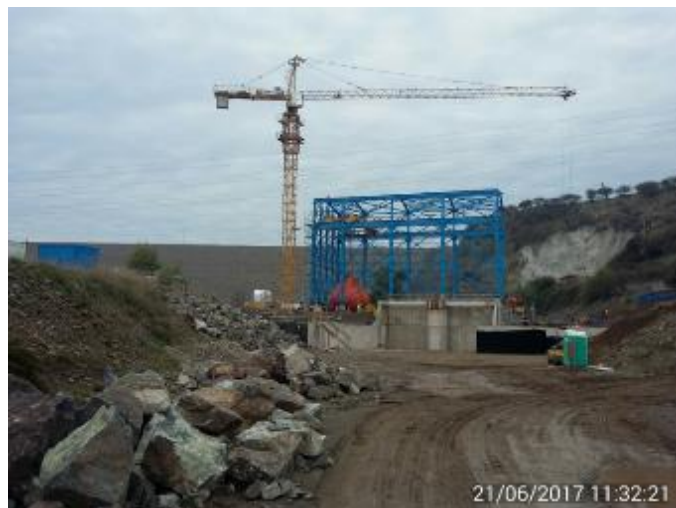
Pruebas de Carga del Puente Grúa de la Casa de Máquinas con 72 Ton reales, con buenos resultados.
