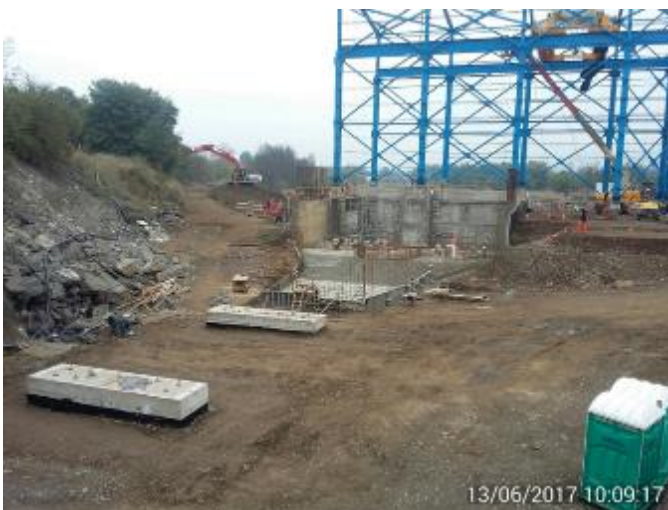
Tratamiento de Junta de Hormigonado de la Losa de la Bifurcación de la Tubería en Presión. Fundaciones F1 y F2.
