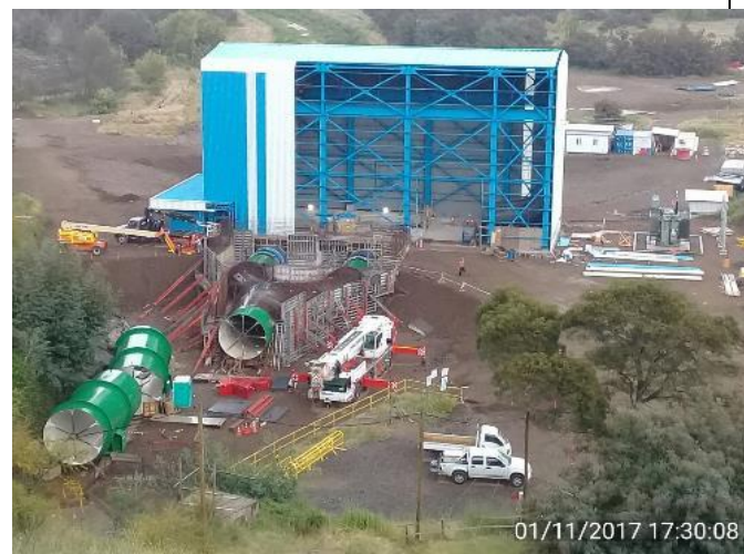
Vista general Casa de Máquinas el 01 de noviembre de 2017.
