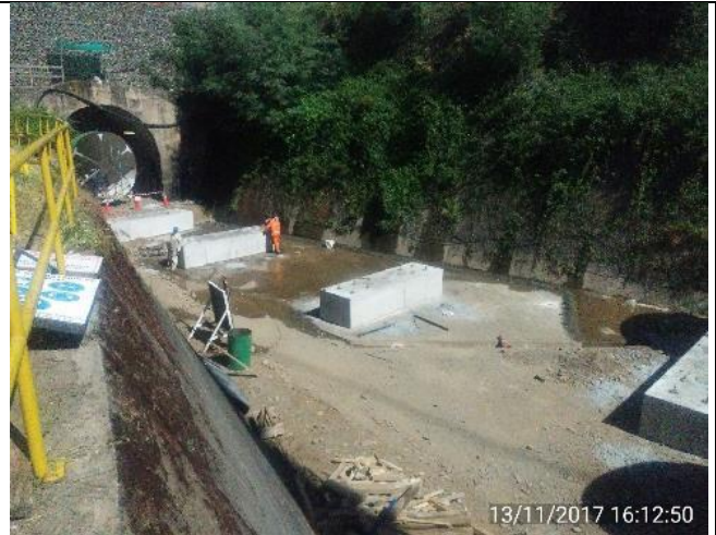
Vista General de las Fundaciones 3, 4, 5 y 6 de la Tubería en Presión a la salida del Túnel Sur.
