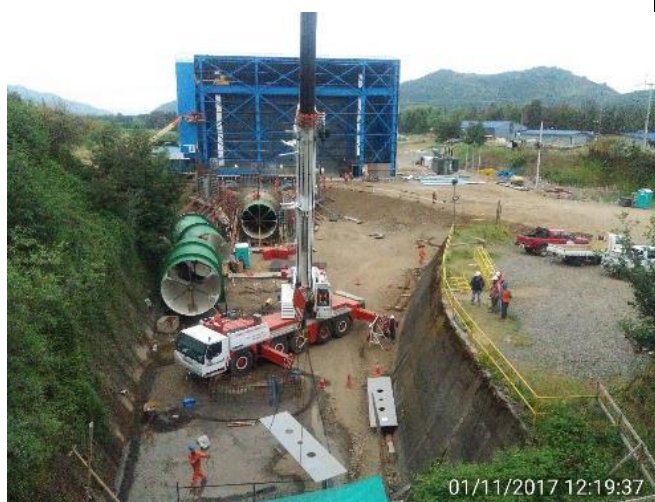
01/11/2017 12:19:37 Vista general de módulos de la Tubería en Presión al 1° de noviembre de 2017.
