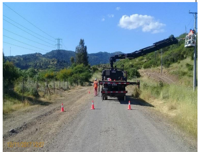
Segregación y uso de EPP en trabajo de la línea de Fibra Óptica.
