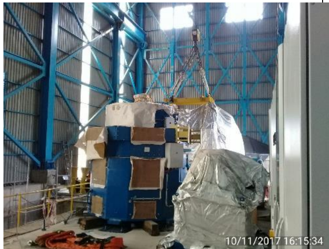
Generador N°1 posicionado sobre su Turbina en la Casa de Máquinas.
