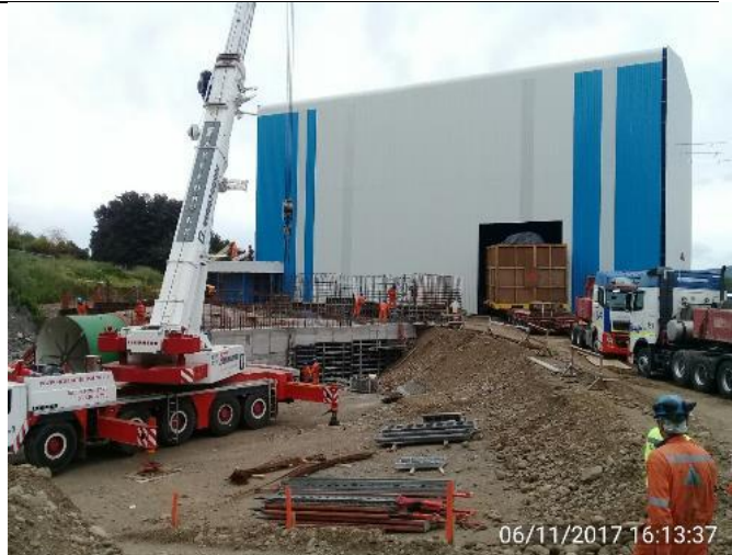
Ingresa, en camión cama baja, el Generador N° 1 al Patio de Maniobras de la Casa de Maquinas.
