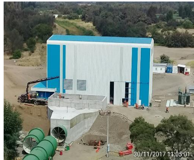
Vista general Casa de Máquinas al 30 de noviembre de 2017.
