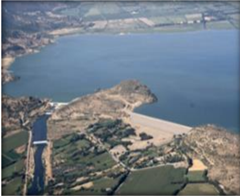
Zona de Presa y Embalse Convento Viejo.
