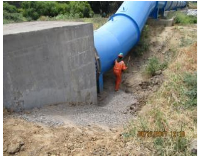
Dren control aguas lluvias y colocación de base para drenaje, Km 0,140.
