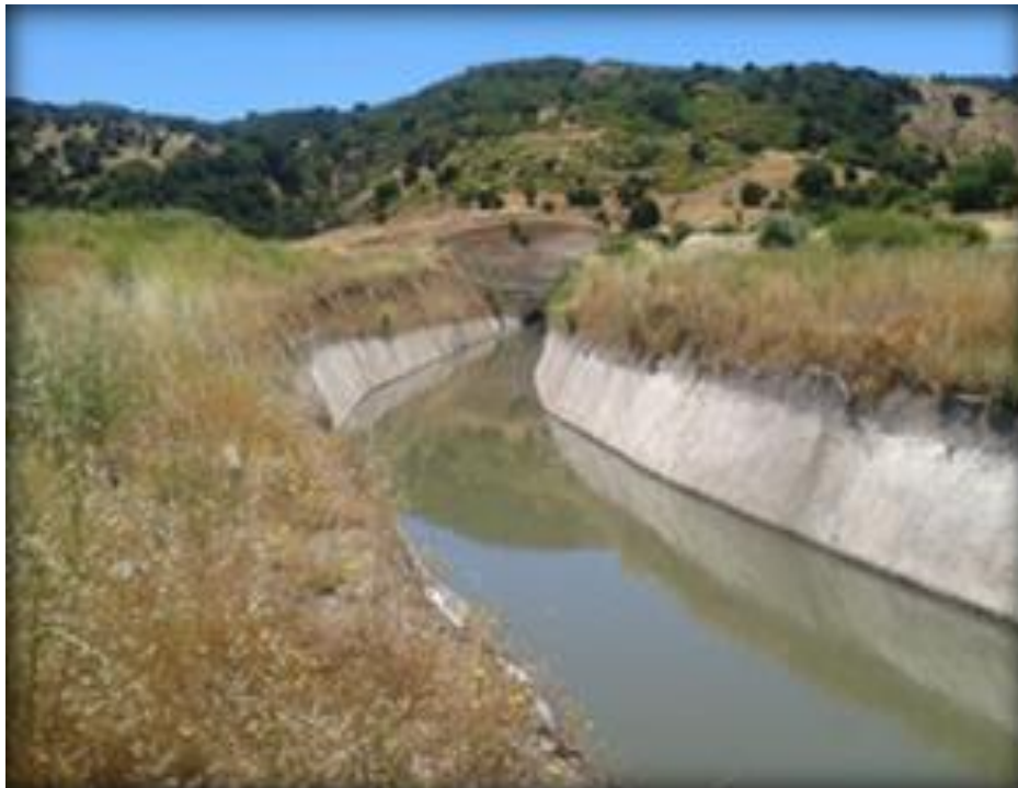
Sector de salida poniente Túnel La Lajuela.
