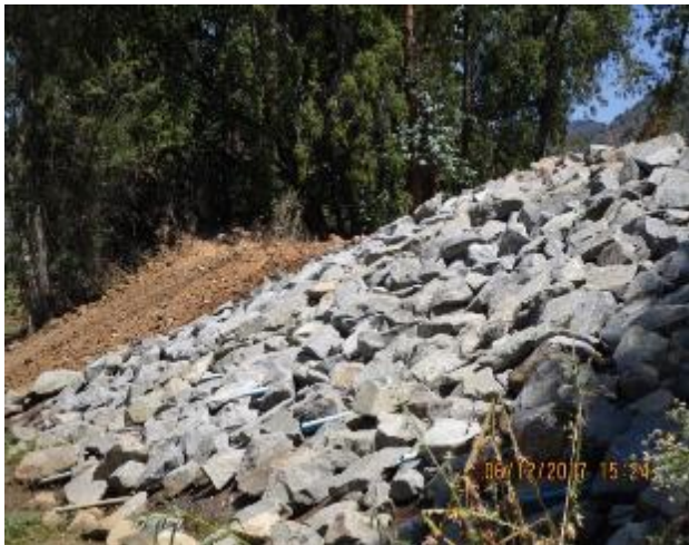
Hormigonado enrocado consolidado lado izquierdo Estero Fortaleza, Km 1,345.
