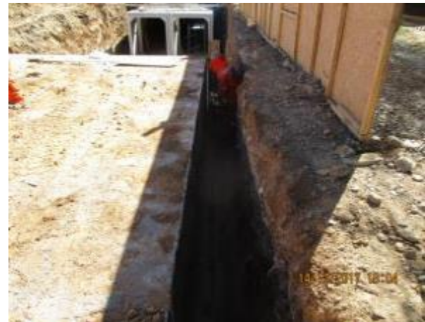
Instalación de cajones y relleno estructural, Km 7,040.
