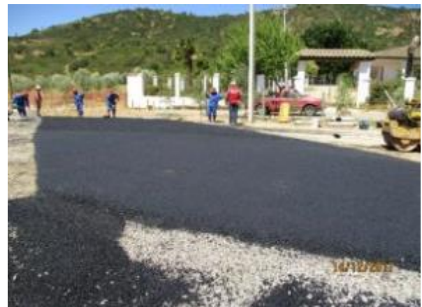
Pavimentación cruce Vial, Ruta I-70-J, Km 15,750.
