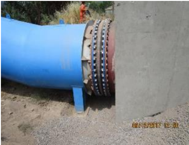
Dren control aguas lluvias y colocación de base para drenaje, Km 0,140.
