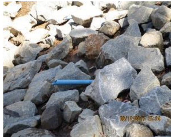
Hormigonado enrocado consolidado lado izquierdo Estero Fortaleza, Km 1,345.
