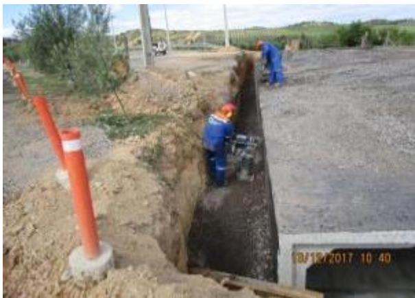
Relleno estructural en cruce Vial, Km 15,750.
