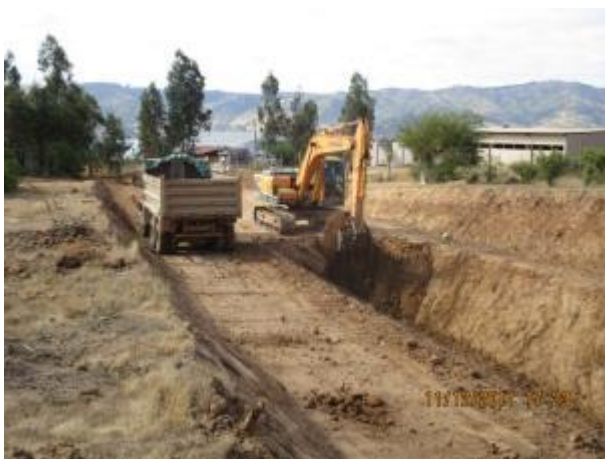
Excavación corte de canal (Km 6,240 - Km 6,320).
