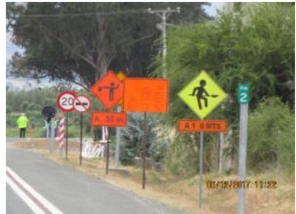
Implementación de señalética y preparación de desvío Ruta I-70-J, Km 15,750.
