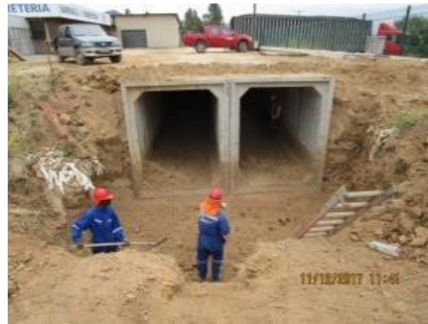
Sello de excavación y emplentillado, Km 6,170.
