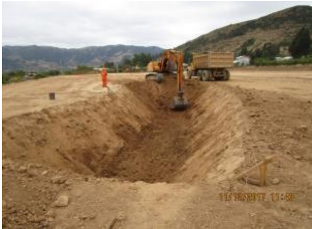
Excavación corte de canal (Km 6,050 - Km 6,140).
