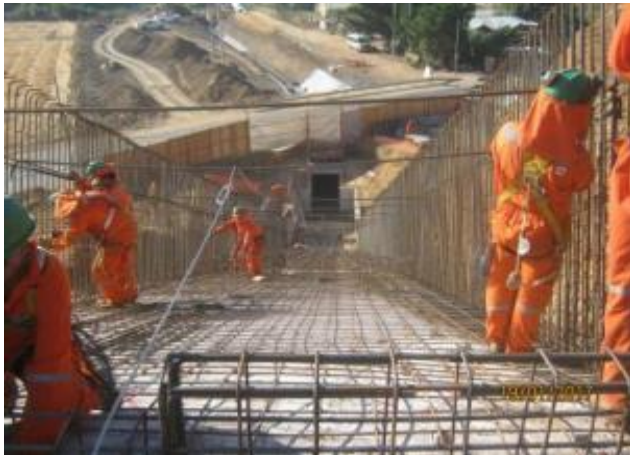
Enfierraduras y hormigonado losa, bajada rebalse CNU; Km 12.200.
