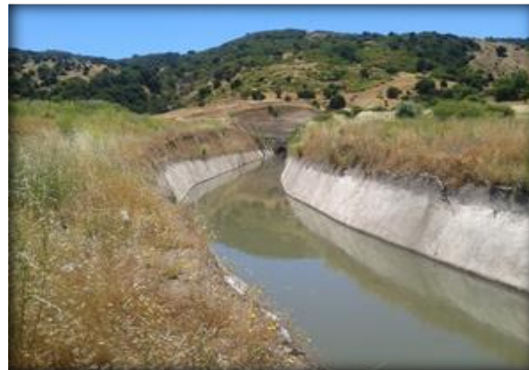
Sector de salida poniente Túnel La Lajuela.
