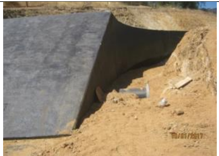
Preparación sello mejorado e instalación tubos prefabricados, cruce camino "La Cabaña" (Km 1,260 – Km 1,310).
