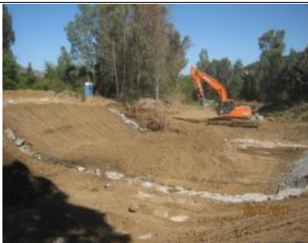
Relleno Estructural Vertedero Sifón Nerquihue
