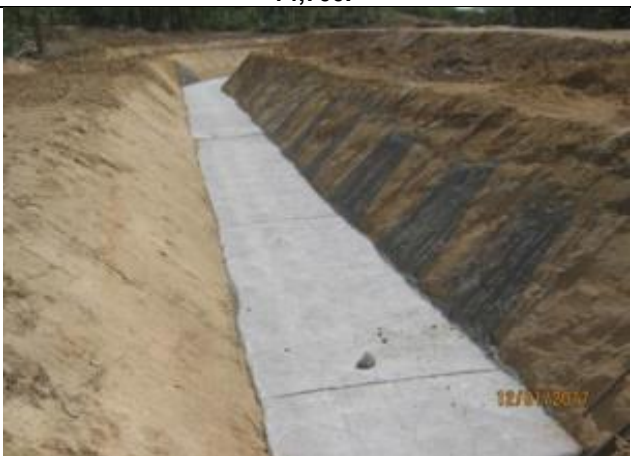
Revestimiento fondo canal (Km 15,020 – Km 15,120).
