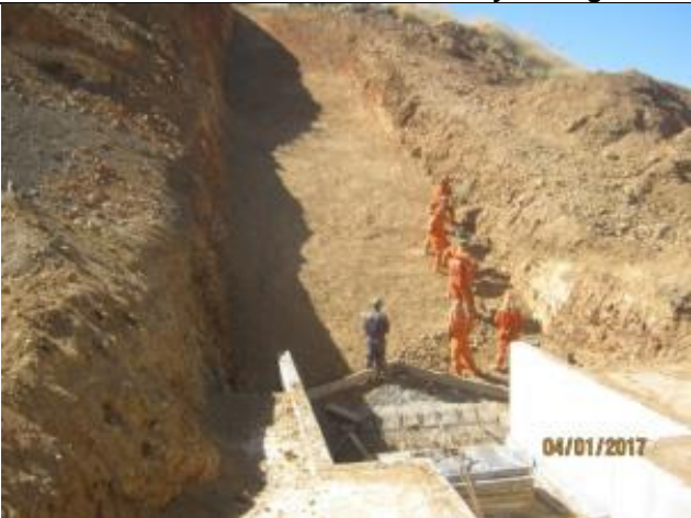
Enfierraduras y hormigonado losa, bajada rebalse CNU; Km 12.200.
