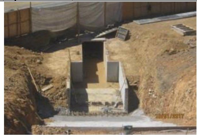
Enfierraduras y hormigonado losa, bajada rebalse CNU; Km 12.200.
