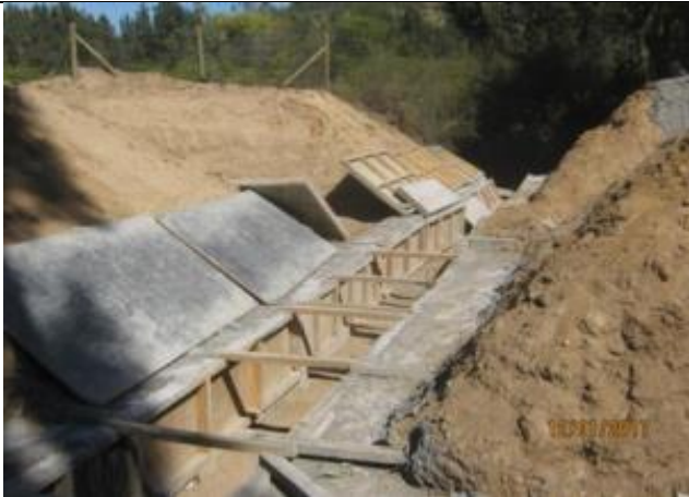
Excavación, hormigonado base y mampostería CQ7, Km 12,970.
