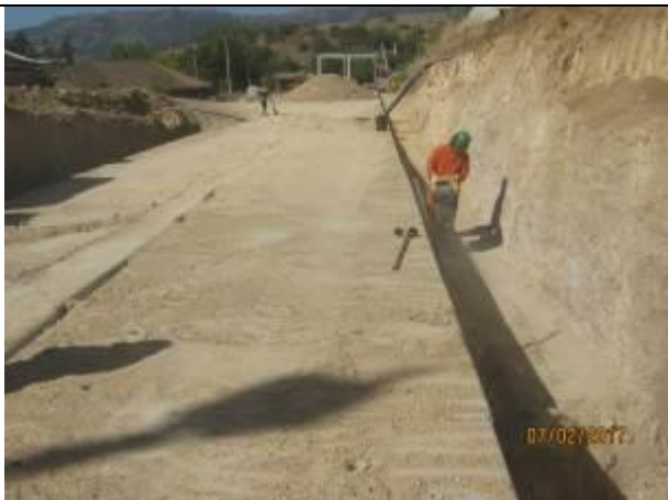
Sello fondo, emplantillado, instalación cajones y rellenos estructurales (Liceo de Lolol); (Km 7,200 – Km 7,380).
