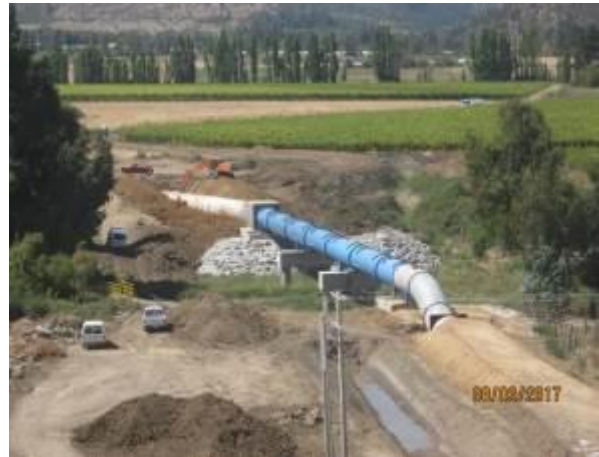
Reparación sellos interior tubería y relleno estructural; (Km 0,215 – Km 0,300).
