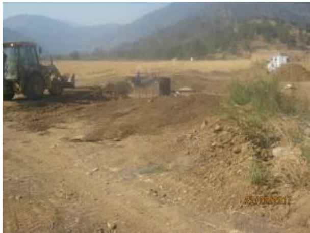
Relleno y reparación sellos interiores sifón; (Km 1,400 – Km 1,700).
