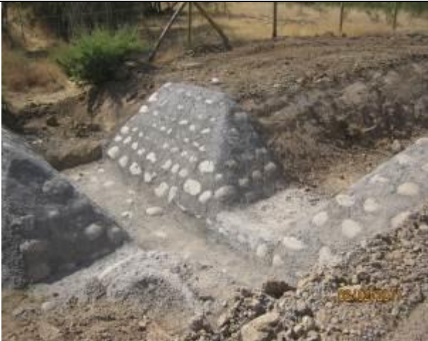
Mampostería en quebrada CQ7; Km 0,015; Km 0,285; Km 0,310 y Km 5,345..
