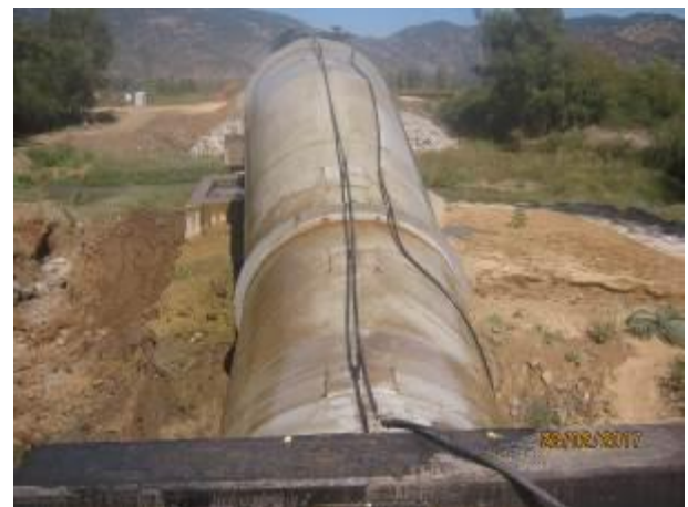
Instalación riego automático por reparación sellos extremos paso aéreo (Km 0,150 – Km 0,210).
