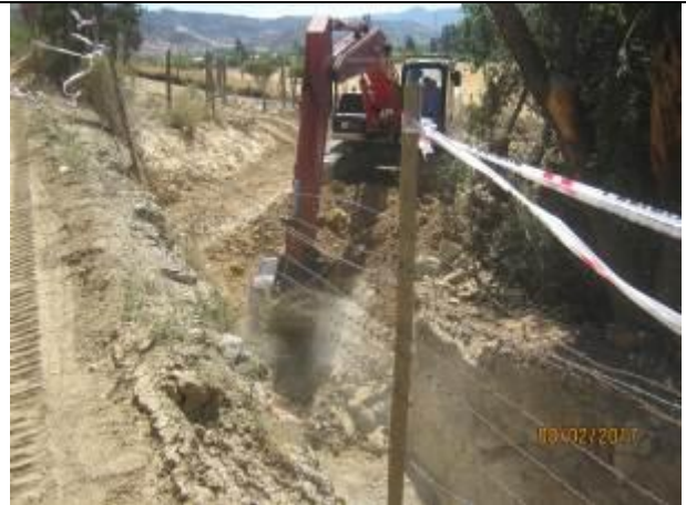
Instalación tubería HDPE; (Km 0,830 – Km 0,844).
