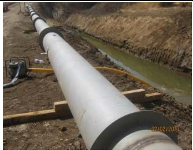
Soldadura y protección bituminosa tubería sifón; (Km 3,220 – Km 3,280).
