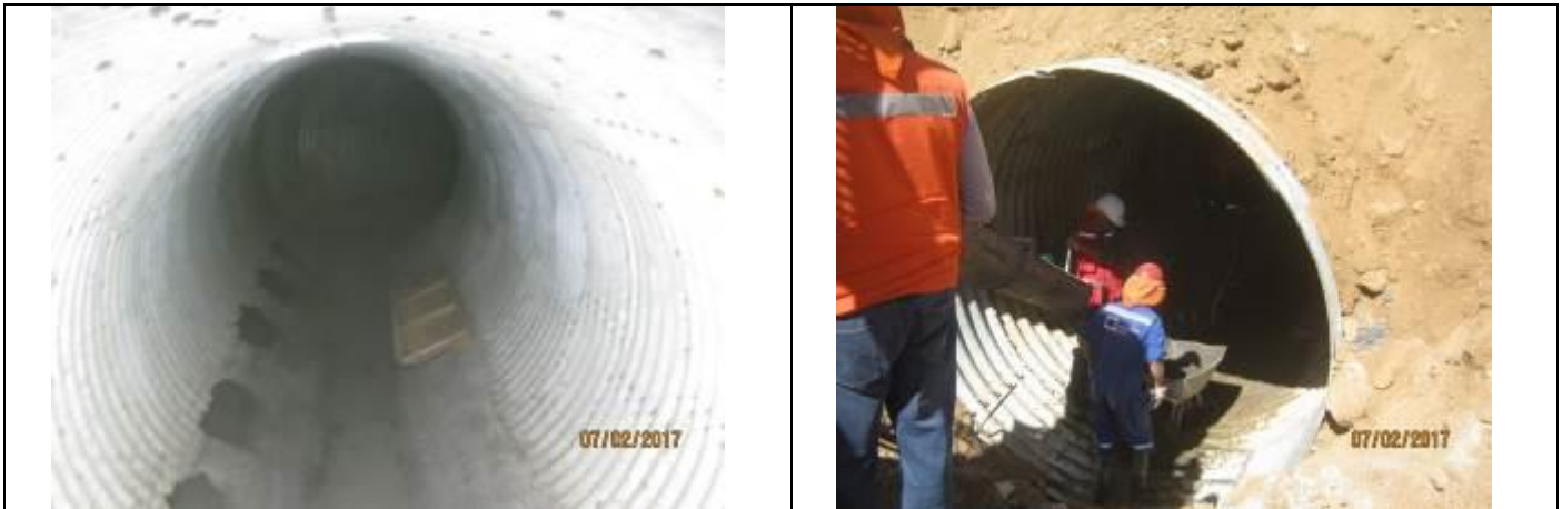
Hormigonado protección contra abrasión; (fondo tubería) (Km 20,600 – Km 20,700).
