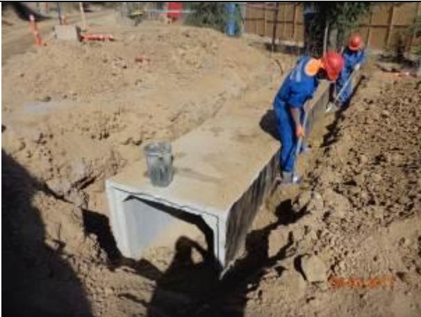
Preparación by-pass, instalación de señales provisorias, excavación, instalación de cajones y relleno estructural, cruce camino público; Km 0,780.
