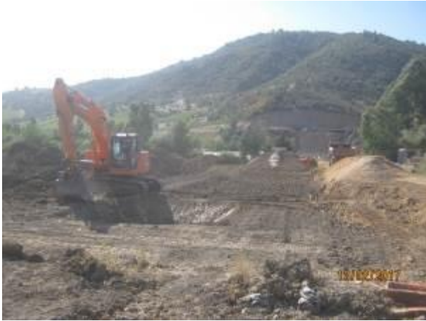
Reparación sellos interior tubería y relleno estructural; (Km 0,215 – Km 0,300).
