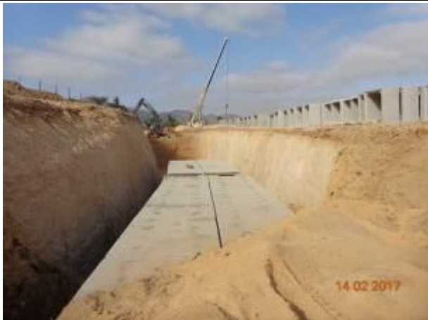
Sello fondo, emplantillado, instalación cajones y rellenos estructurales (Liceo de Lolol); (Km 7,200 – Km 7,380).
