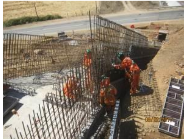
Enfierraduras y moldajes muros, canal de descarga aliviadero.
