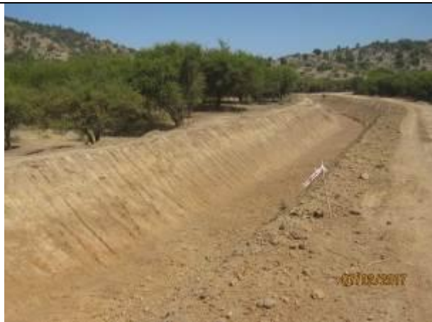
Excavación corte de Canal; (Km 16,200 – Km 16,740).
