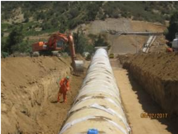
Reparación sellos interior tubería y relleno estructural; (Km 0,215 – Km 0,300).
