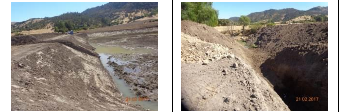
Movimiento de Tierra, Tranque Los Cardos Sur, Km 0,015 aprox. Canal Panamá
