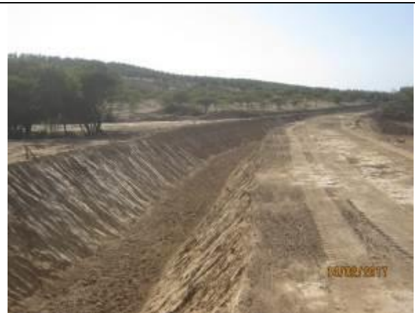
Excavación corte de Canal; (Km 16,200 – Km 16,740).
