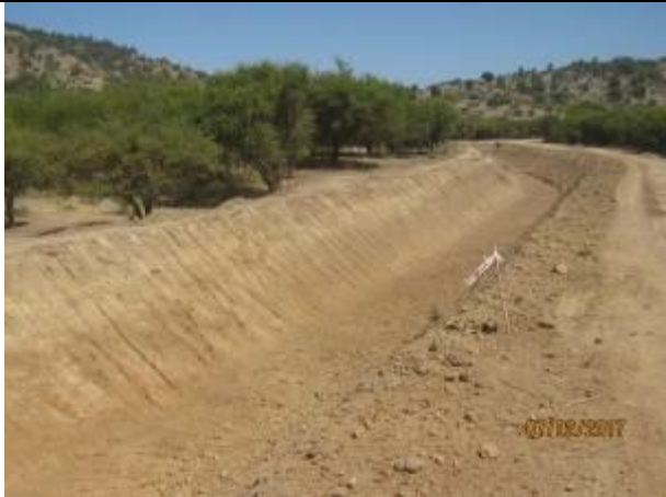
Excavación corte de Canal; (Km 16,200 – Km 16,740).
