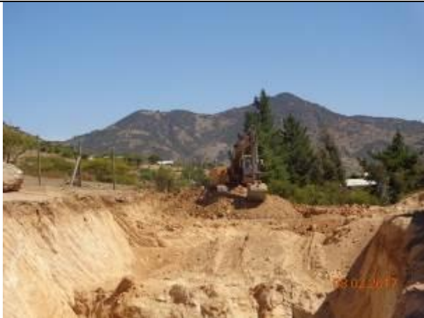
Movimiento de tierra; (Km 7,350 – Km 7,550).
