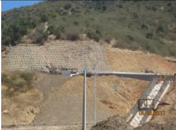
Instalación contrapesos en malla protección talud; Km 12,240.
