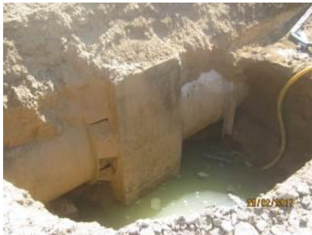
Reparación sellos curva horizontal sifón C-4; (Km 0,780 – Km 0,800).
