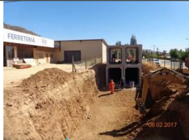
Excavación, instalación de cajones prefabricados y relleno estructural, acceso a predio, sector ferretería; (Km 6,180 – Km 6,280).
