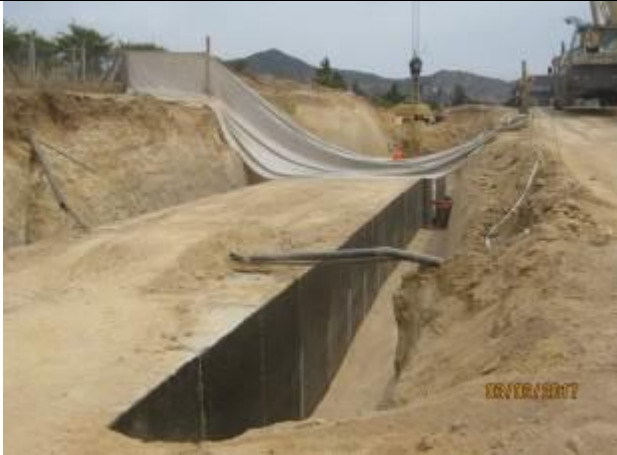
Sello fondo, emplantillado, instalación cajones y rellenos estructurales (Liceo de Lolol); (Km 7,200 – Km 7,380).
