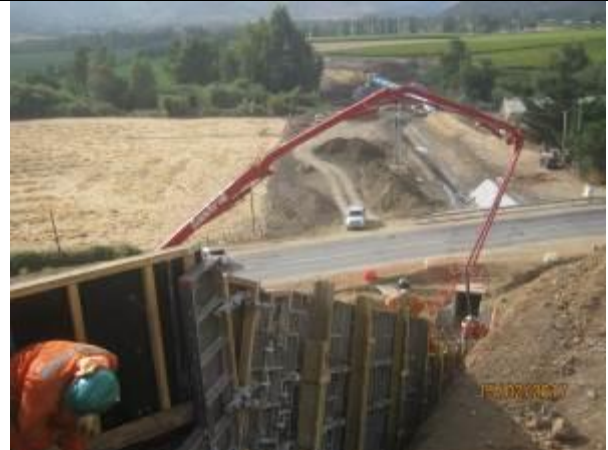
Hormigonado muros y losa superior, canal de descarga aliviadero.
