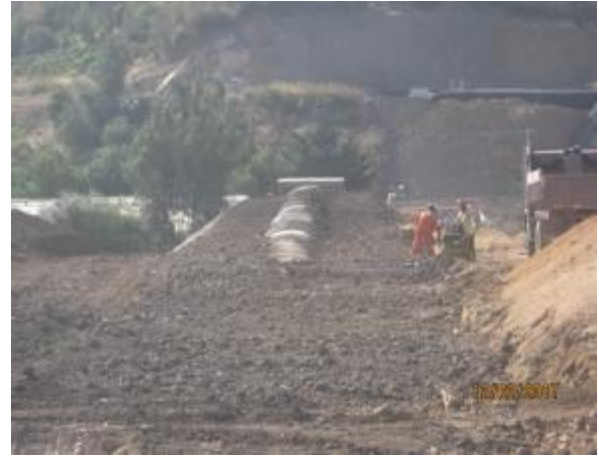
Reparación sellos interior tubería y relleno estructural; (Km 0,215 – Km 0,300).
