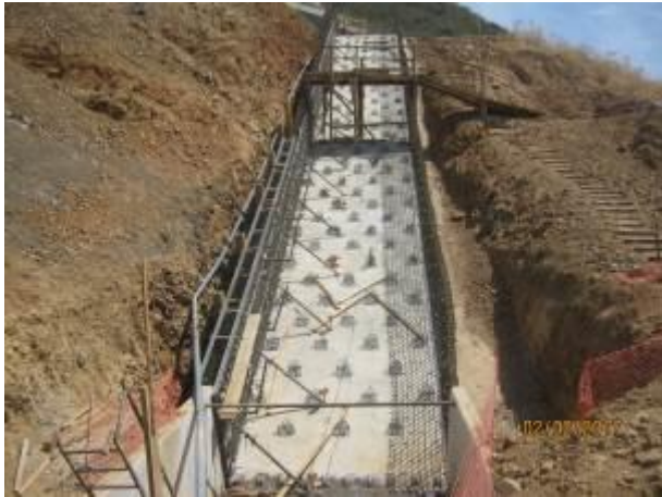
Enfierraduras y moldajes muros, canal de descarga aliviadero.
