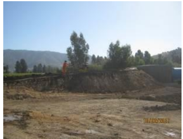
Compactación de terraplén; Km 0,240.
