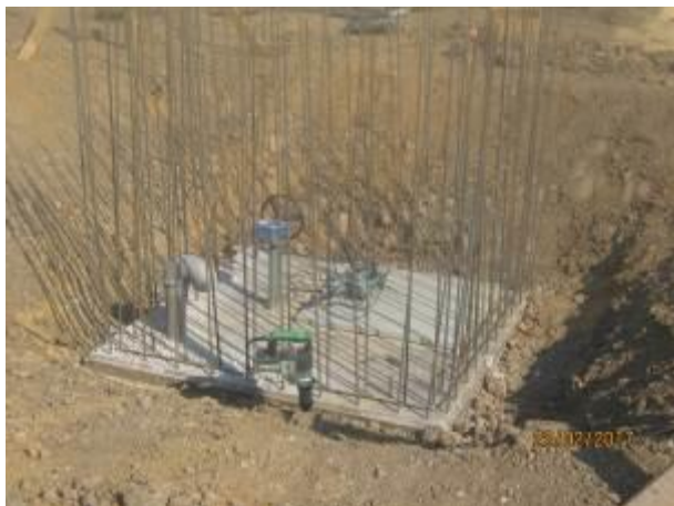
Instalación armadura para subir muros cámara de desagüe N° 2; Km 0,300.
