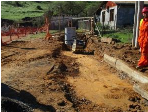
Cambio de servicio de alcantarillado en sector urbano, calle Las Pataguas.
