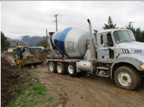
Hormigonado de enrocado consolidado
