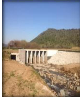
Bocatoma Canal Norte Unificado, barrera frontal.
