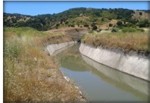
Sector de salida poniente Túnel La Lajuela.
