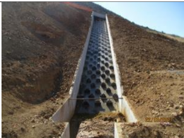
Hormigonado disipadores, canal descarga aliviadero
