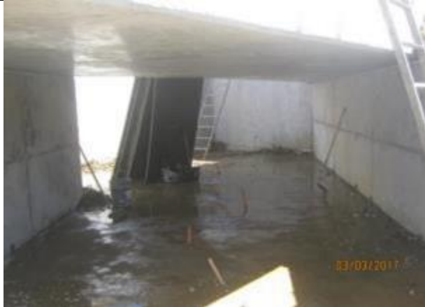
Descimbre moldaje losa superior y preparación moldaje disipadores, Canal de descarga aliviadero.
