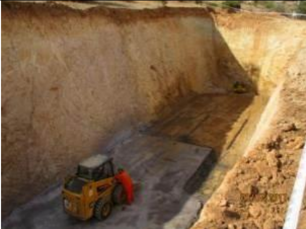
Sello fondo, emplentillado, instalación cajones y rellenos estructurales (Km 7,340 – Km 7,400).
