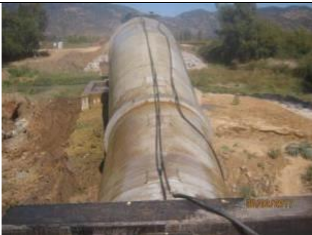
Instalación riego automático por reparación sellos en extremos paso aéreo sifón (Km 0,150 – Km 0,210).
