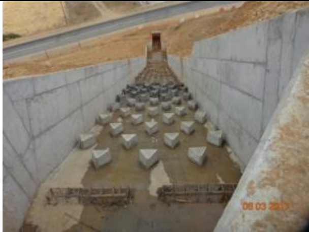
Relleno estructural costado muros, canal de descarga aliviadero.
