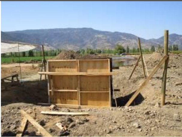
Preparación enfierradura y moldajes cámara desagüe sifón N°2, Km 0,300
