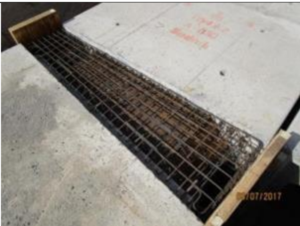
Enfierradura, moldaje y hormigonado, curvas horizontales (Km 7,320 – Km 7,340).
