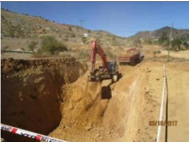
Excavación, preparación sello fundación y emplentillado (Km 7,460 – Km 7,560).
