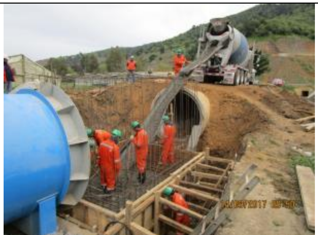
Hormigonado de Machón de curva C2 de Sifón Nerquihue, Km 0,140.
