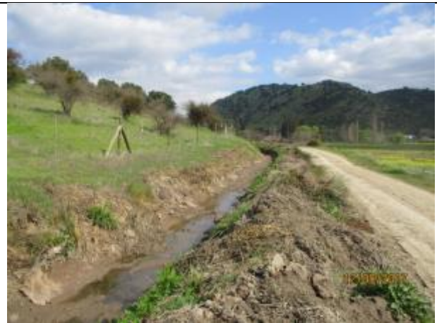
Limpieza de Canal (Km, 0,000 – Km 0,520).
