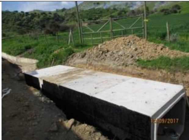
Instalación cajones paso predial, Km 0,040.
