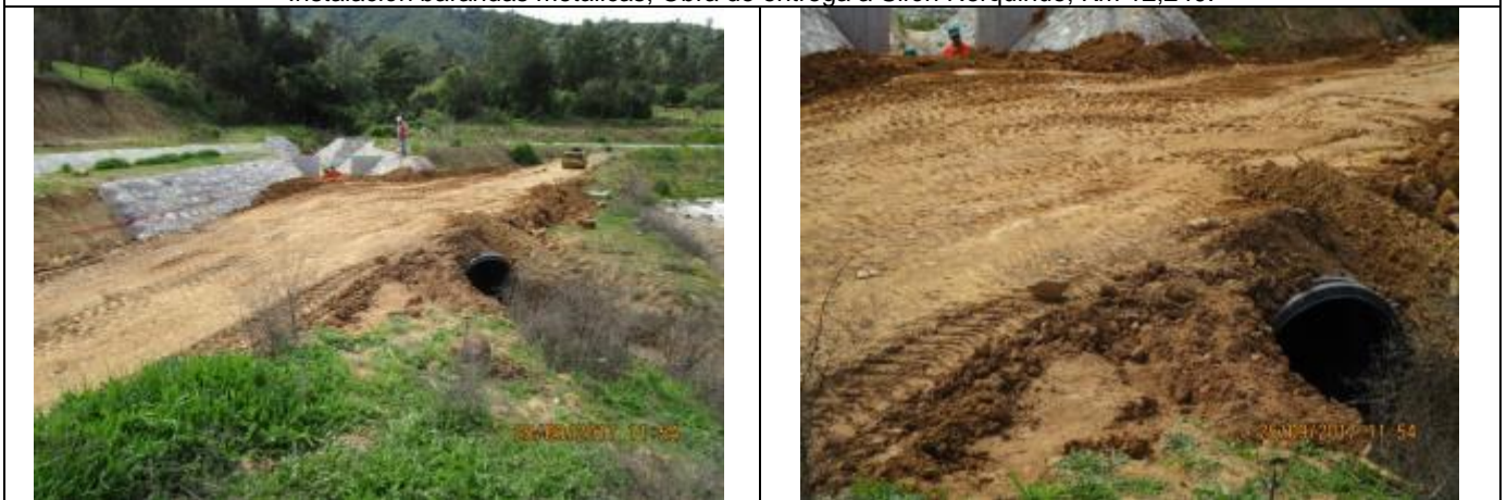
Instalación de tubería HDPE descarga de CQ7, en tranque Mujica, Km 14,820.
