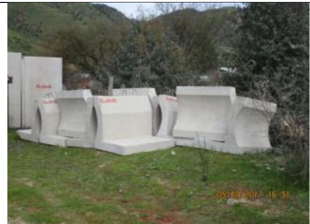
Descarga de cajones y parapetos, Km 5,800
