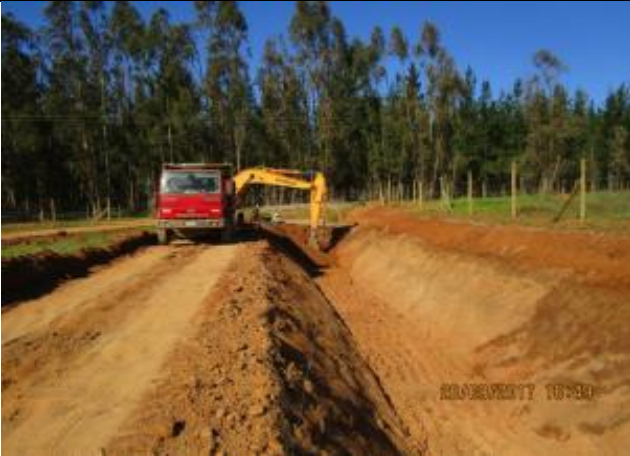
Excavación corte de canal (Km 49,400 – Km 49,510).
