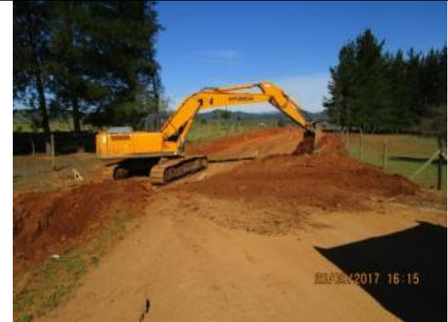
Excavación corte de canal (Km 47,400 – Km 47,700)
