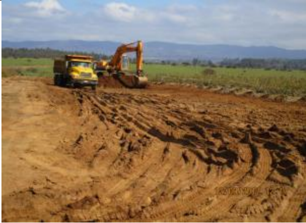
Escarpe plataforma de canal (Km 52,470 - Km 52,580).
