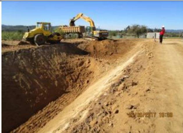
Excavación corte de canal (Km 52,470 - Km 52,580).
