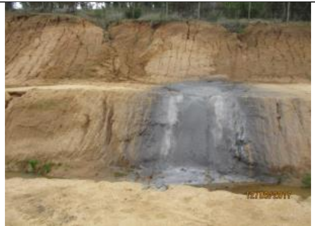
Descarga a canal, Km 21,780.
