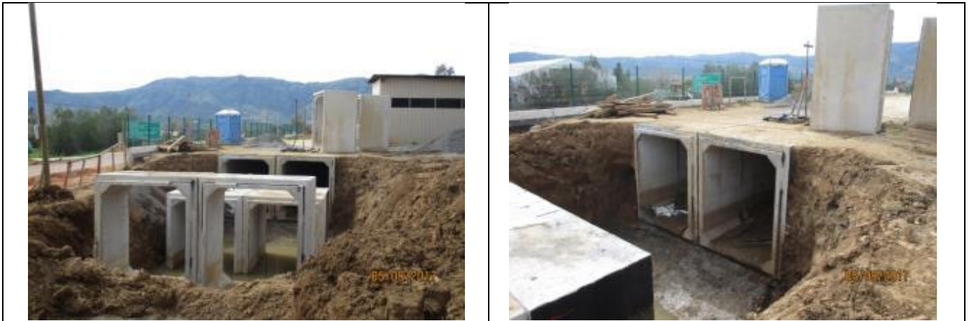
Cajones Prefabricados (Km 6,250 – Km 6,270).
