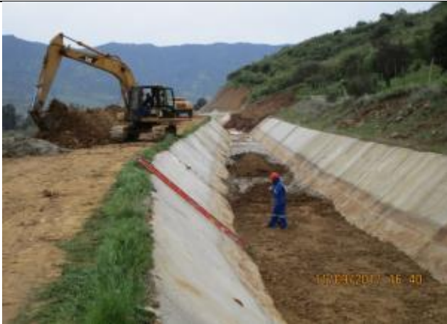
Obras provisoria en el canal Norfte Unificado, cama de apoyo para instalación de tubería HDPE (Km 11,860 – Km 12,040).
