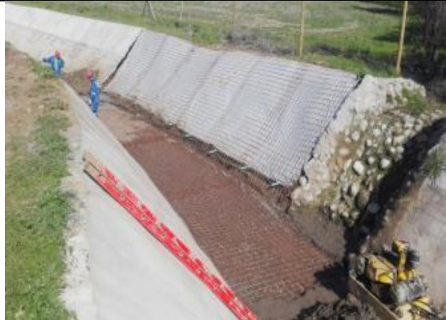
Trabajos de reparación en el Canal Norte Unificado, fondo y talud del canal, más el revestimiento (Km 5,880 – Km 5,900).
