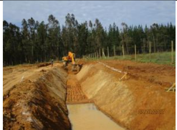
Excavación corte de canal (Km 49,400 – Km 49,510).
