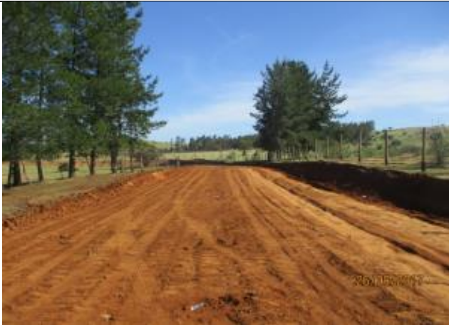
Preparación plataforma de canal (Km 47,600 – Km 47,800).
