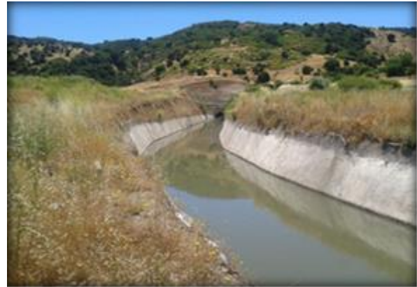
Sector de salida poniente Túnel La Lajuela.
