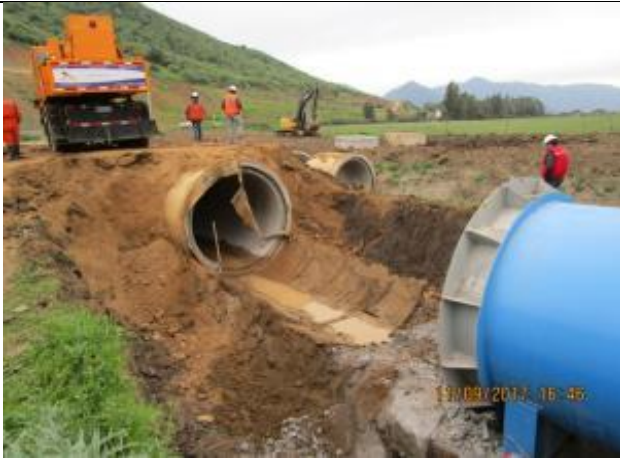
Excavación y armadura de Machón curva C2 de Sifón Nerquihue, Km 0,140.
