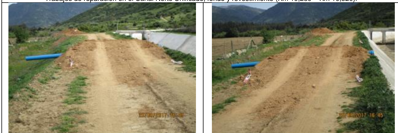
Construcción de terraplén para instalación de tubería PVC de descarga del CNU, Km 10,660.
