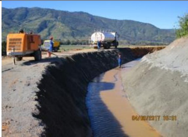
Revestimiento de Canal (Km 4,700 – Km 4,780).
