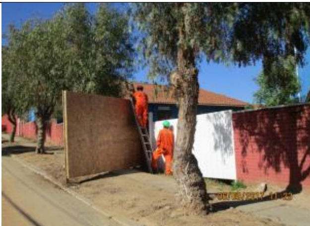
Instalación de pantallas acústicas en Zona Urbana (Calle Las Pataguas).
