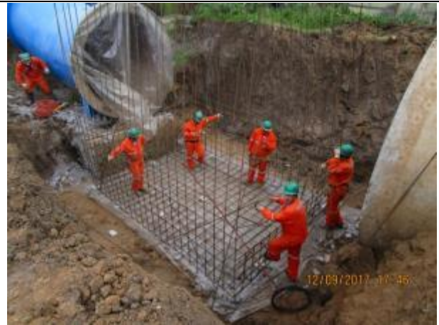
Excavación y armadura de Machón curva C2 de Sifón Nerquihue, Km 0,140.
