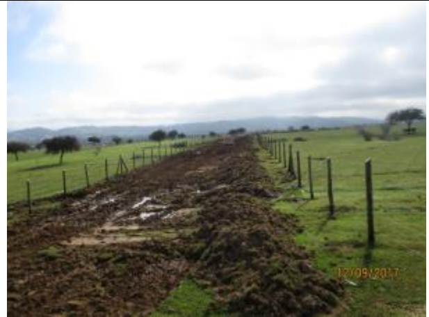
Escarpe plataforma (Km 52,280 – Km 52,380).
