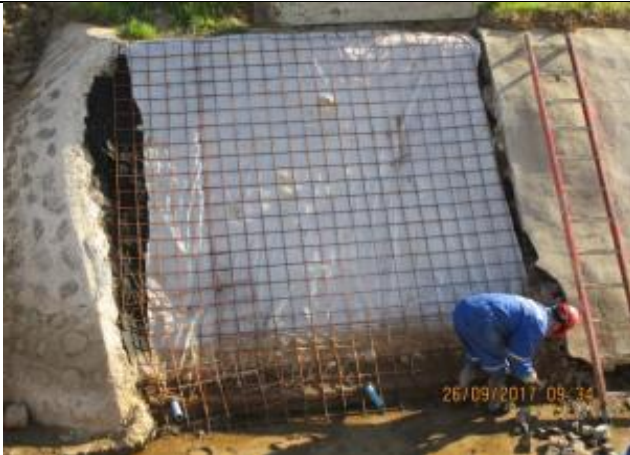
Trabajos de reparación en el Canal Norte Unificado, talud y revestimiento (Km 5,880 – Km 5,900).
