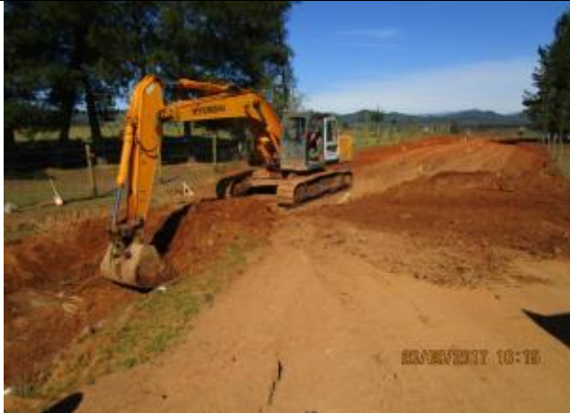
Excavación corte de canal (Km 47,400 – Km 47,700)
