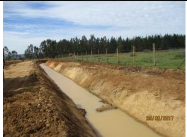
Excavación corte canal (Km 49,100–Km 49,200).
