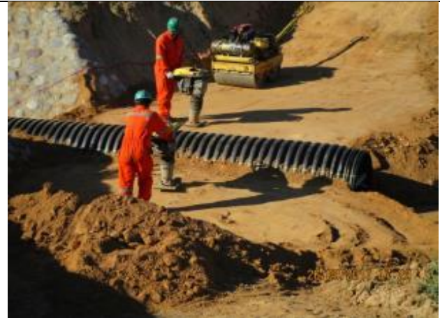
Instalación de tubería HDPE en paso descarga al tranque La Vega Oeste, Km 30,300.
