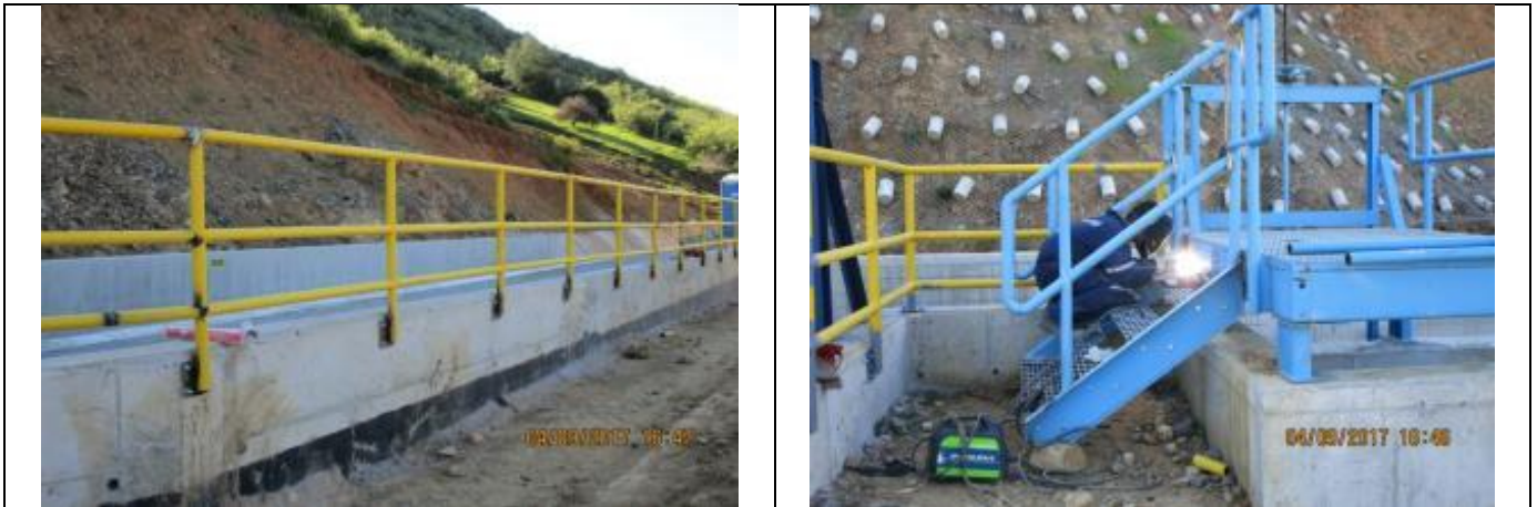
Instalación barandas metálicas, Obra de entrega a Sifón Nerquihue, Km 12,240.
