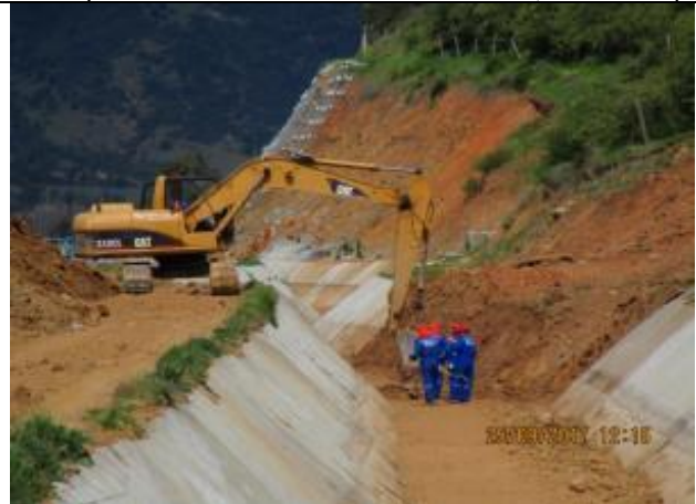
Obras provisoria en el canal Norfte Unificado, Instalación de tubería HDPE, (Km 11,851 - Km 12,080)
