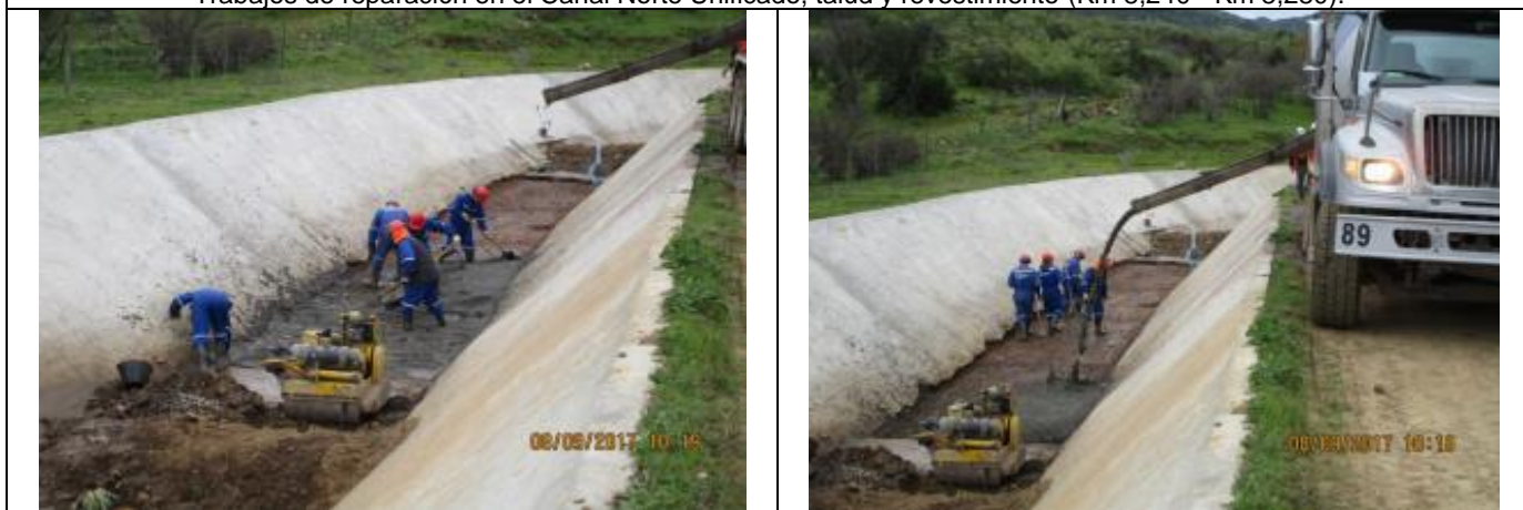
Trabajos de reparación en el Canal Norte Unificado, fondo y revestimiento (Km 10,280 – Km 10,320).
