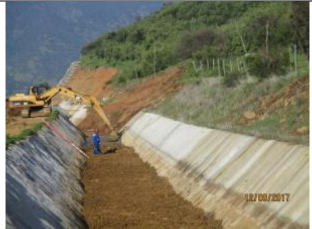
Obras provisoria en el canal Norfte Unificado, cama de apoyo para instalación de tubería HDPE (Km 11,860 – Km 12,040).
