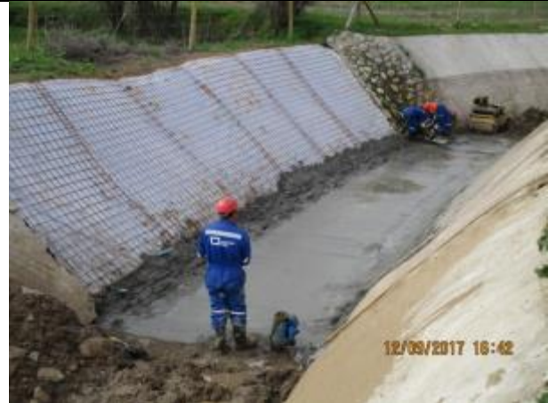
Trabajos de reparación en el Canal Norte Unificado, fondo y talud del canal, más el revestimiento (Km 5,880 – Km 5,900).
