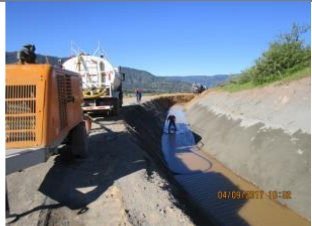
Excavación en roca, Km 4,900.
