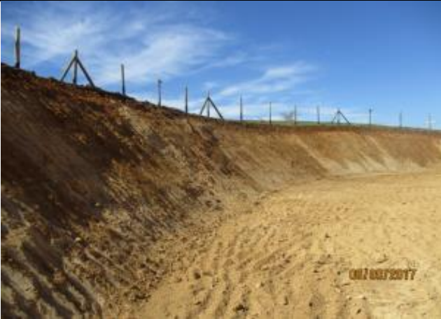
Preparación plataforma de canal (Km 48,520 – Km 48,460).
