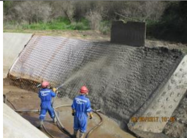
Trabajos de reparación en el Canal Norte Unificado, talud y revestimiento (Km 5,880 – Km 5,900).
