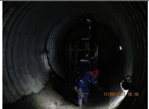
Inyección y construcción de piso túnel Linner, Km 7,780.
