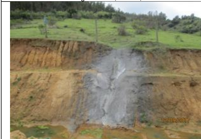
Descarga a canal, Km 23,700.
