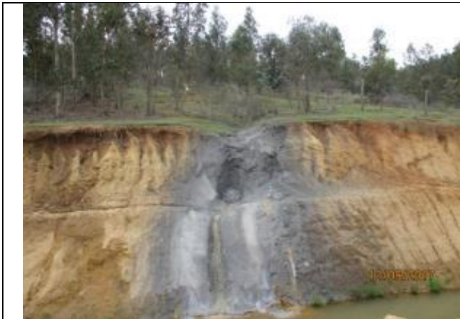
Descarga a canal, Km 21,700.
