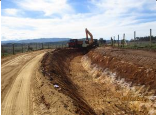
Excavación corte de canal (Km 48,960 – Km 49,060).
