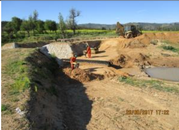
Instalación de tubería HDPE en paso descarga al tranque La Vega Oeste, Km 30,300.
