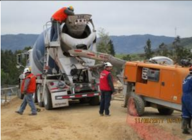
Inyección y construcción de piso túnel Linner, Km 7,780.
