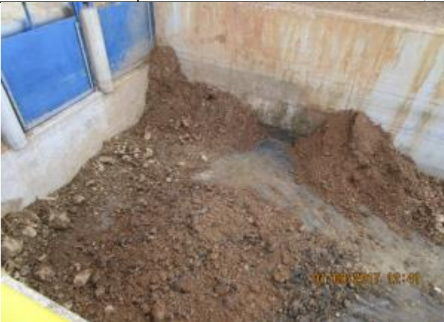
Trabajos de reparación, retiro material de derumbe, Km 12,240 en el canal Norte Unificado.
