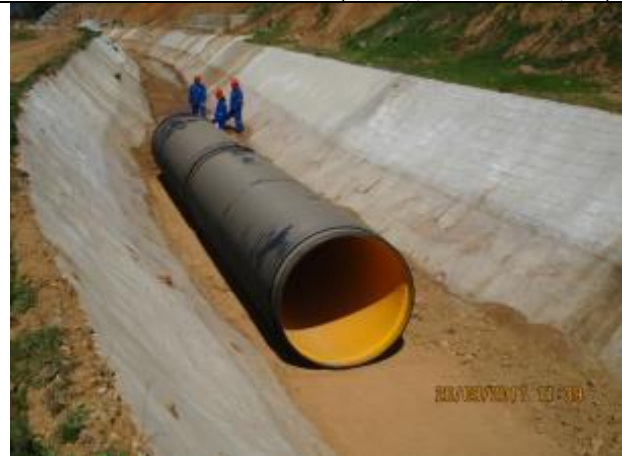
Obras provisoria en el canal Norfte Unificado, Instalación de tubería HDPE, (Km 11,851 - Km 12,080)
