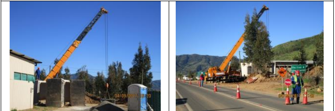
Instalación de cajones paso predial, Km 6,250.
