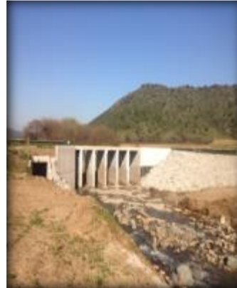
Bocatoma Canal Norte Unificado, barrera frontal.
