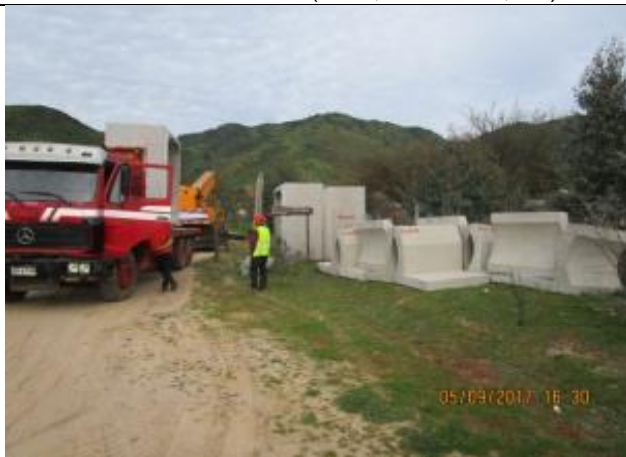
Descarga de cajones y parapetos, Km 5,800
