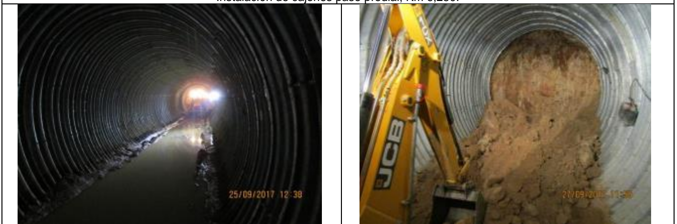
Excavación de túnel Linner, Km 7,780.
