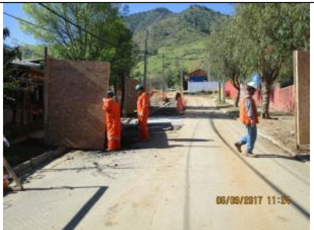
Instalación de pantallas acústicas en Zona Urbana (Calle Las Pataguas).
