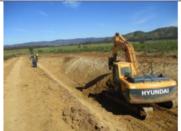
Excavación corte de canal (Km 52,470 - Km 52,580).
