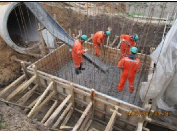
Hormigonado de Machón de curva C2 de Sifón Nerquihue, Km 0,140.
