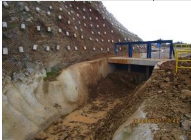
Trabajos de reparación, retiro material de derumbe, Km 12,240 en el canal Norte Unificado.
