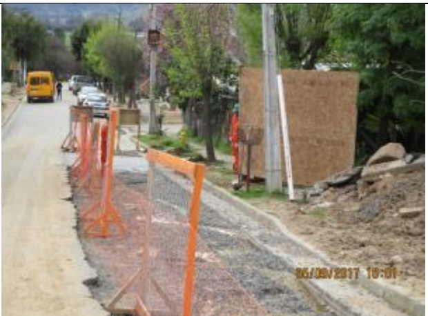
Pavimentación de veredas e instalación de pantallas acústicas en Zona Urbana (Calle Las Pataguas).
