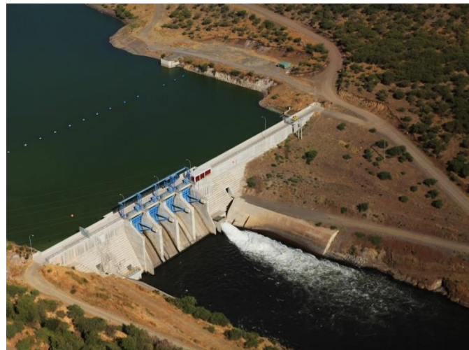
Presa auxiliar del embalse, descarga al canal
