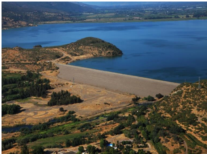
Embalse Convento Viejo, presa principal.
