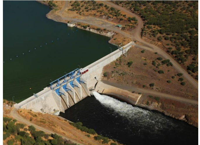
Presa auxiliar del embalse, descarga al canal
