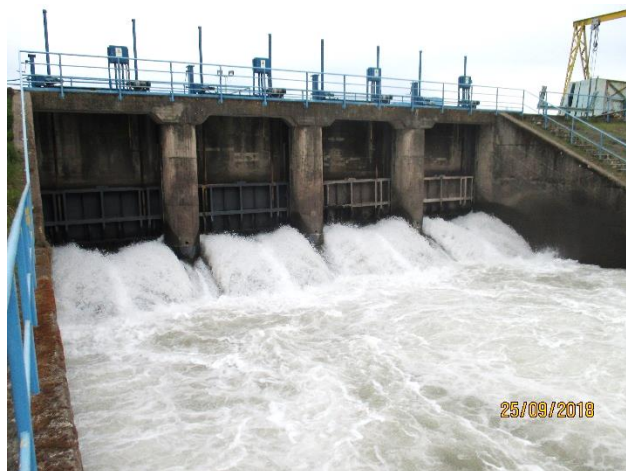
Bocatoma del canal Teno-Chimbarongo
