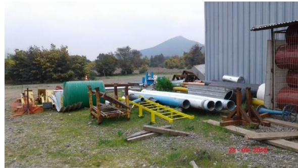
FOTO 2: Patio de acopio, Central Hidroeléctrica.
