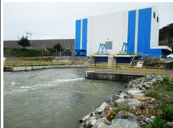
Vista Casa de Máquinas, Instalación techo zona válvulas Mariposa
