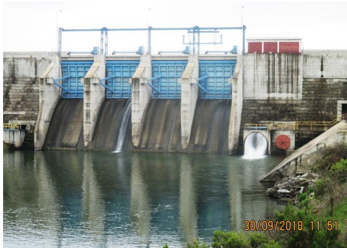
Presa Auxiliar (Panorámica desde aguas abajo)
