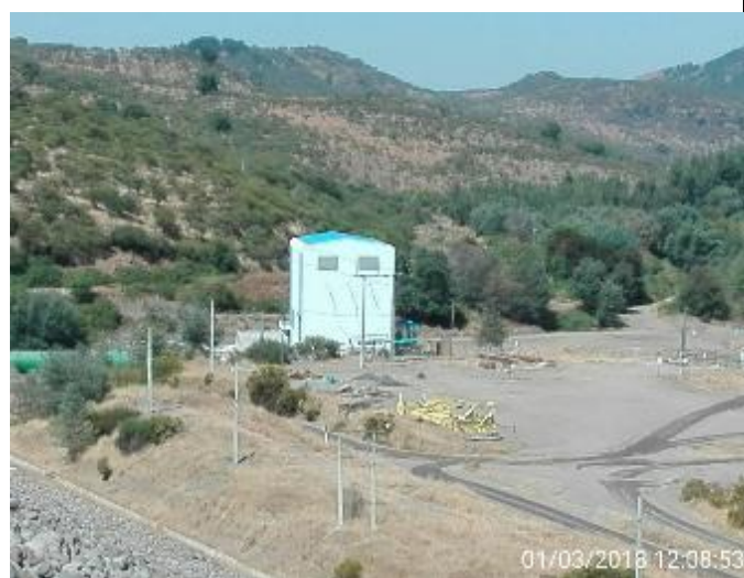
Vista general del lado Norte de la Casa de Máquinas el día primero de marzo de 2018.
