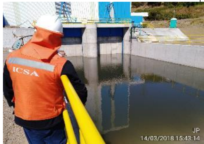
Prueba Hidrostática para verificar la estanqueidad hasta el nivel 237.500 msnm. Incluye los Manhole de las Turbinas. Canal de Descarga inundado.
