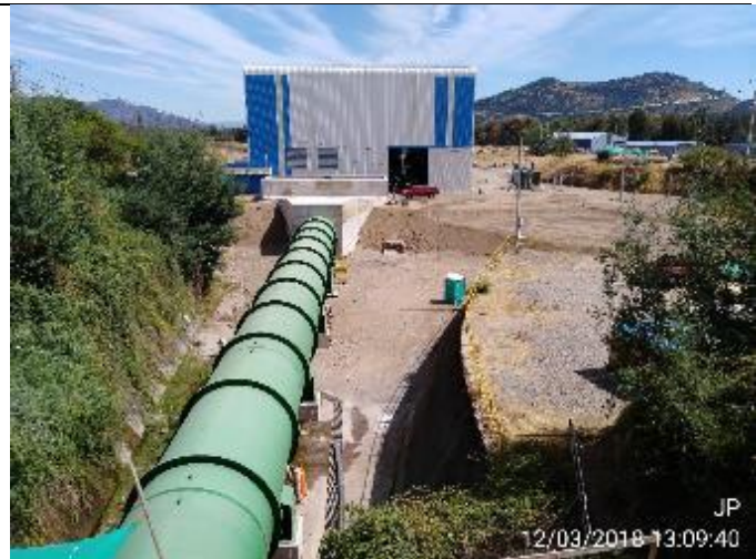
Inicio de las Pruebas Hidrostáticas de la Tubería en Presión.
