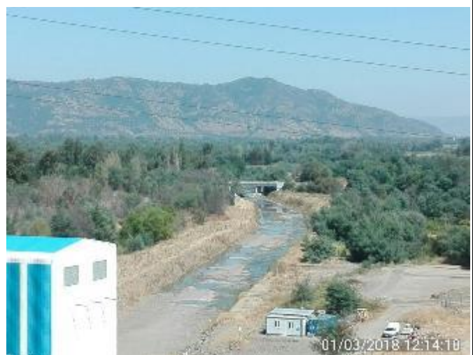
Vista parcial de la Casa de Máquinas, Canal de Descarga, Canal de Restitución y Puente San Luis.
