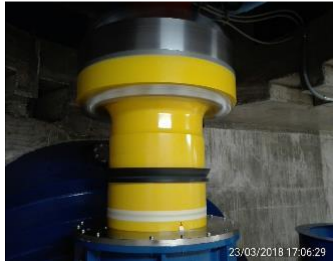
Unidad Nº1. Girando por primera vez a la velocidad de 300 rpm, sin carga. Bidas Ejes Turbina/Generador.
