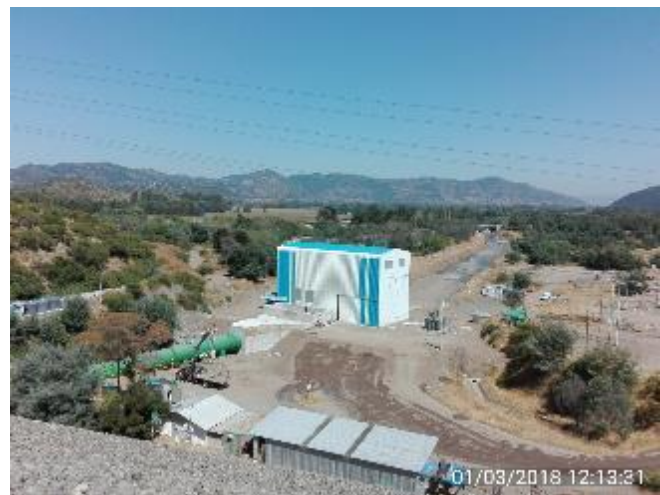
Tubería en Presión conectada a las Válvulas de las Turbinas lista para el inicio de las pruebas Hidrostáticas. Toda la Tubería de Aducción está en Precomisionamiento con 20 mca
