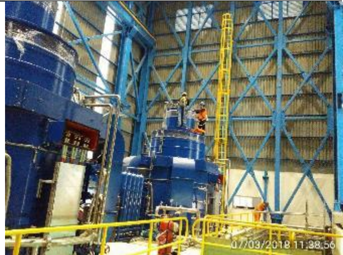
Trabajos en el Sistema Oleo Hidráulico de la Unidad N° 2.
