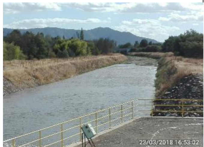
Flujo inicial en el Canal de Descarga y de Restitución para llevar a la Unidad N°1 a la velocidad de 300 rpm. Velocidad de trabajo.
