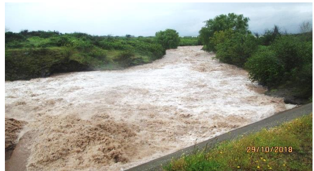
Canal Teno-Chimbarongo en Km 13,660 (Caudal medio registrado en estación satelital = 39,624 m 3 /s)
