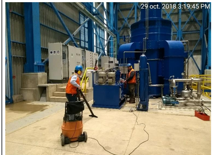
Personal de mantenimiento mecánico realizando limpieza de unidad hidráulica del sistema de regulador de velocidad, y aspirado del piso principal de casa de máquinas
