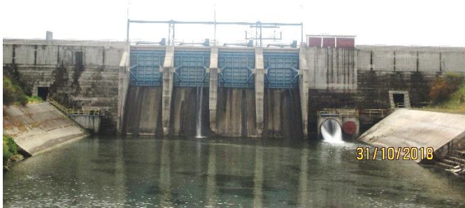
Presa Auxiliar (Panorámica desde aguas abajo)
