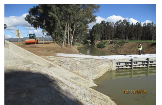
Poza Quiahue N° 2 de ramal “El Molino”; vista general
