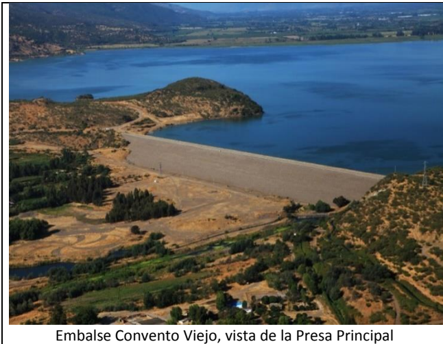
Embalse Convento Viejo, vista de la Presa Principal
