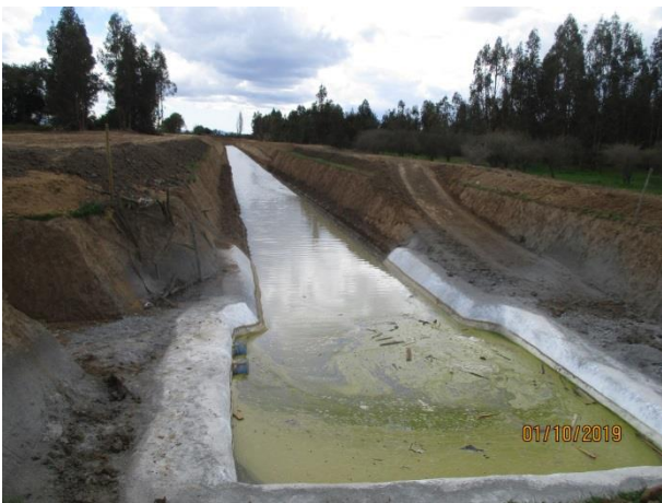
NCS; ramal “El Molino 2.1 A”; sentina terminal del canal. Punto de extracción por bombeo y de forma gravitacional (tubos a la derecha). En la fotografía en una prueba hidráulica.
