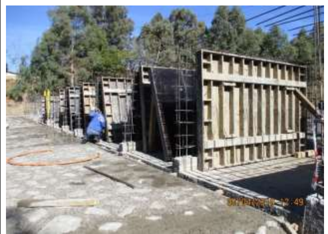
Canal El Fondo; Proyección de hormigón de la transición anterior
