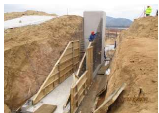
NCS; ramal “El Molino 1”, enfierradura y moldaje obra de entrega a canal (km 0,000 - km 0,040).
