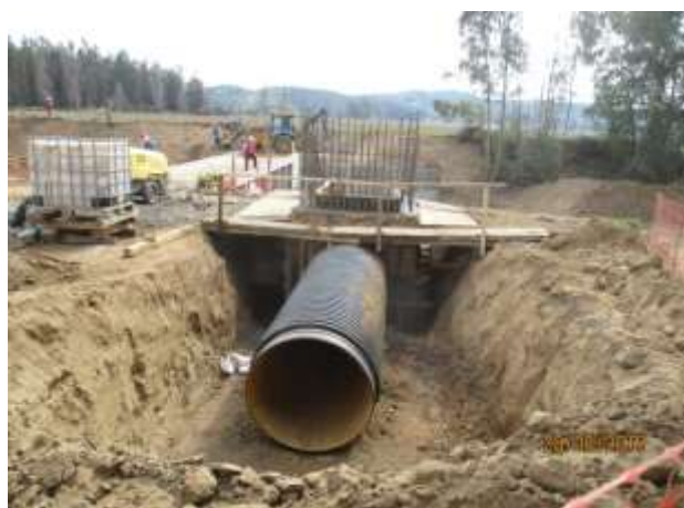
NCS; ramal “El Molino 2.1”, hormigón primera elevación obra de entrega a canal (km 0,000).
