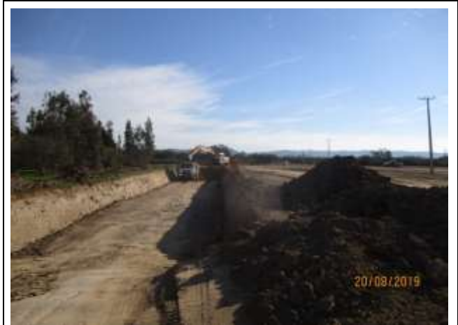
NCS; ramal “El Molino 2.1 A”, preparación plataforma (km 1,820 - km 1,870).
