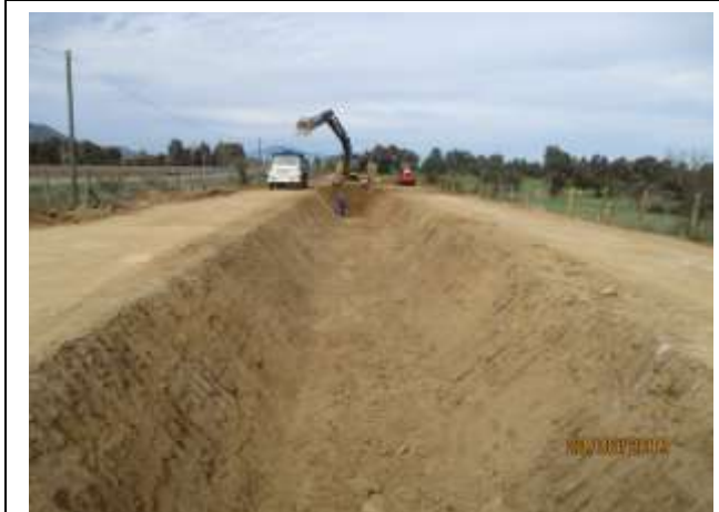
NCS; ramal “El Molino 1”, corte de canal (km 1,180 - km 1,420).
