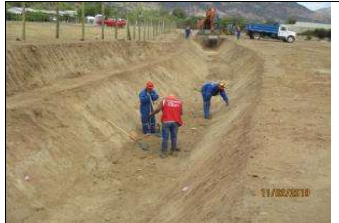
Canal El Fondo (Quiahue), trabajos de terminación del fondo del canal (km 0.040 - km 0.180).
