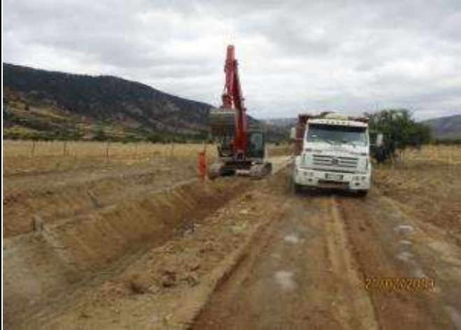
Preparación de mesa y corte de canal, km 2,000.
