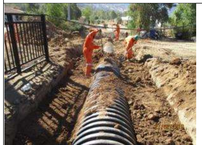
Relleno estructural en tubería HDPE en zona de canal soterrado, km 1,520.
