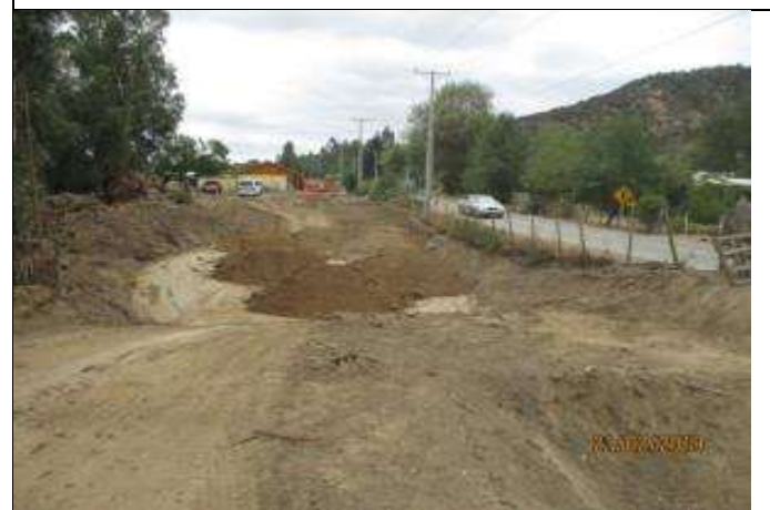
Conformación de plataforma de canal, km 1,580.
