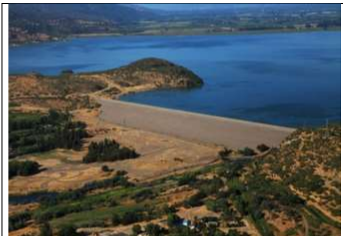
Embalse Convento Viejo, vista de la Presa Principal
