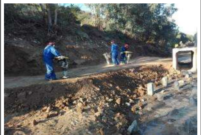
Ramal El Fondo; poza Quiahue 1, relleno estructural ribera norte
