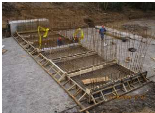
Ramal El Molino; poza Quiahue 2, armaduras y encofrados losa inferior cajones barrera transparente
