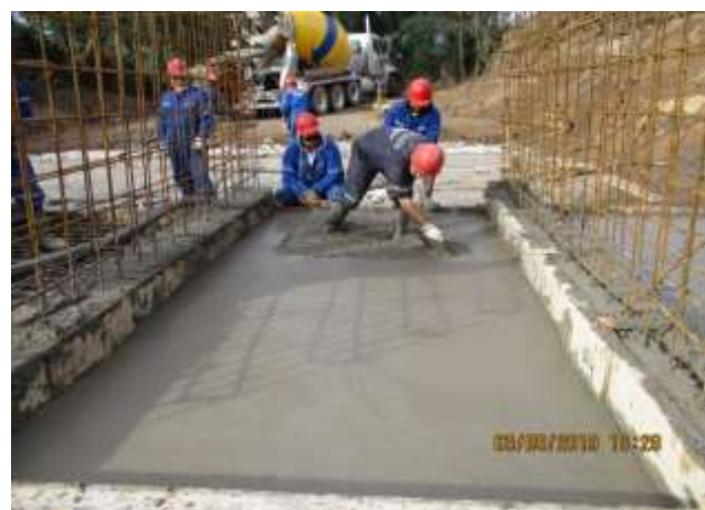
Ramal El Molino; poza Quiahue 2, vaciado del hormigón de la losa inferior de los cajones de la barrera transparente
