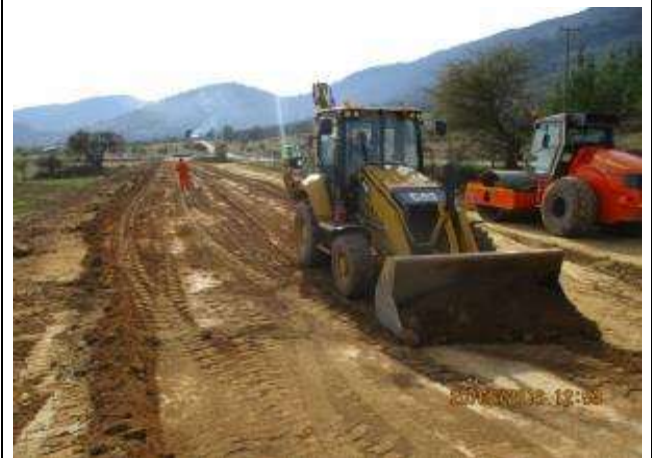
Ramal El Fondo; terraplén (km 4,200 – km 4,520).
