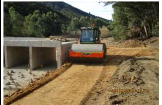
Ramal El Fondo; poza Quiahue 1, relleno estructural ribera sur
