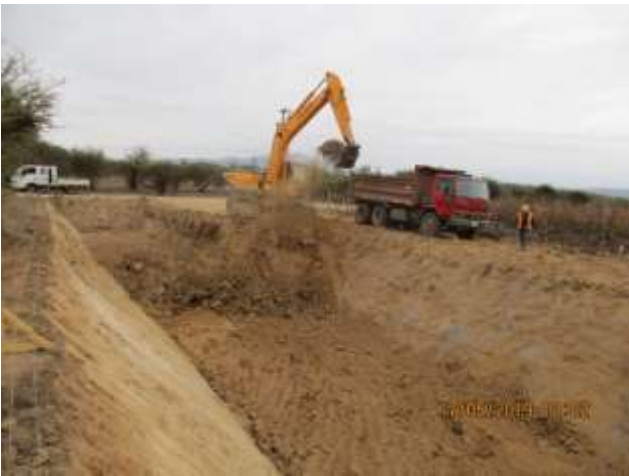
Canal El Molino; Corte TCN para conformar la plataforma en el fondo, allí se excavará el canal.
