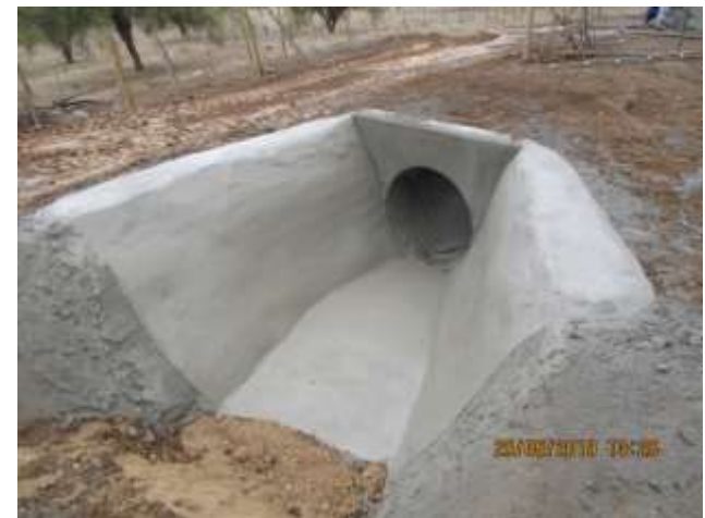
Canal El Fondo; Transiciones canal-tubería, pasos prediales (km 3,940; km 4,080 y km 4,300).
