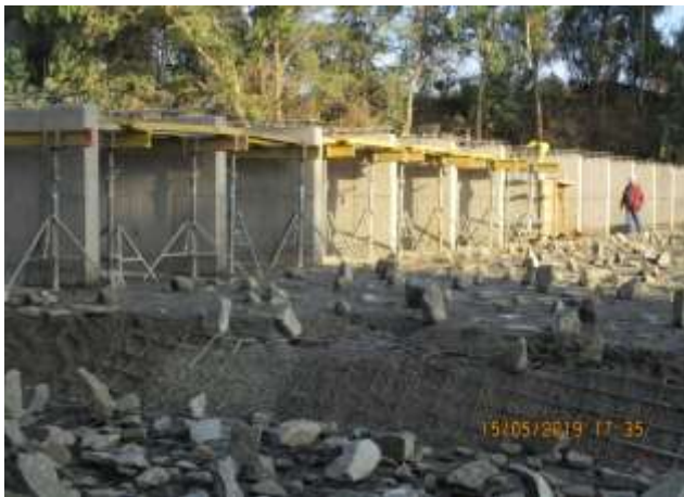
Canal El Fondo; Instalación encofrado de la losa sobre superior de cajones.
