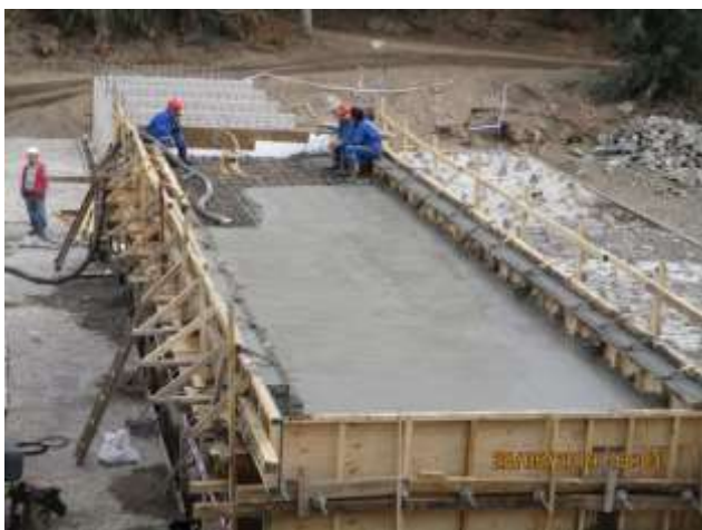
Canal El Fondo; Vaciado de hormigón losa mitad oriente barrera.
