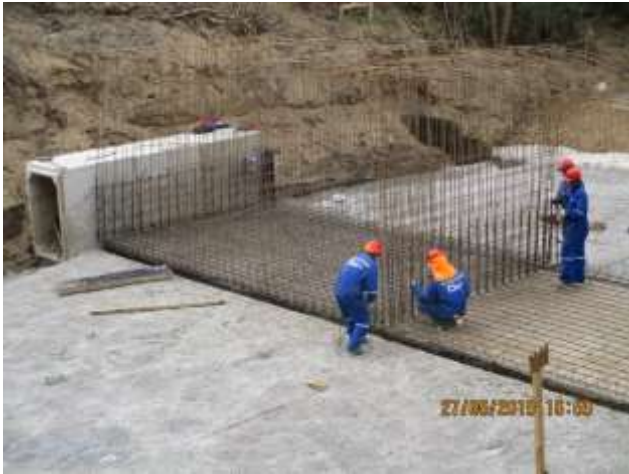
Canal El Molino; Instalación armaduras losa inferior de cajones y muros de la barrera
