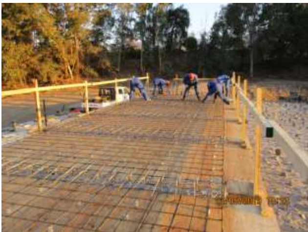
Canal El Fondo; Colocación de armaduras de la losa.
