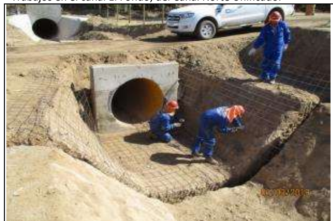
Colocación de malla ACMA en transición muro boca cruce predial km 0,040
