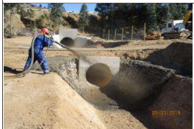
Proyección de hormigón de la transición anterior
