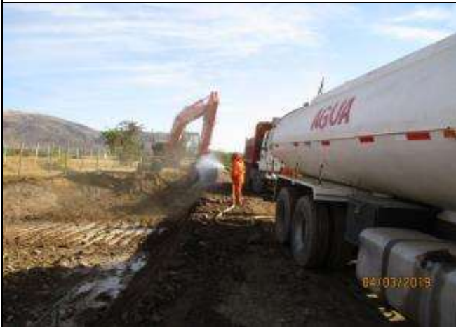
Conformación de plataforma km 2,110 al km 2,130.
