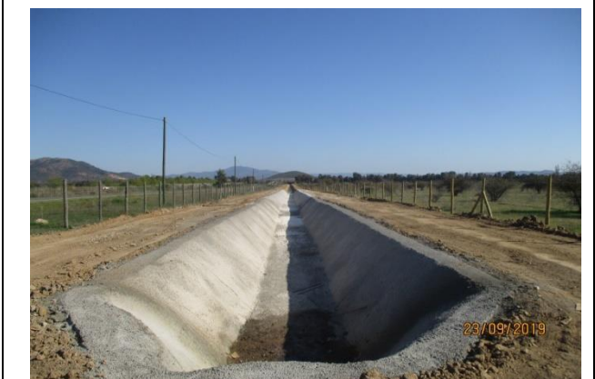
NCS; ramal “El Molino 1; revestimiento canal (km 0,640 – km 1,060)
