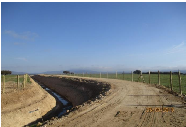
NCS; ramal "El Molino 2.1"; canal en tierra (km 1,250 – km 3,400)
