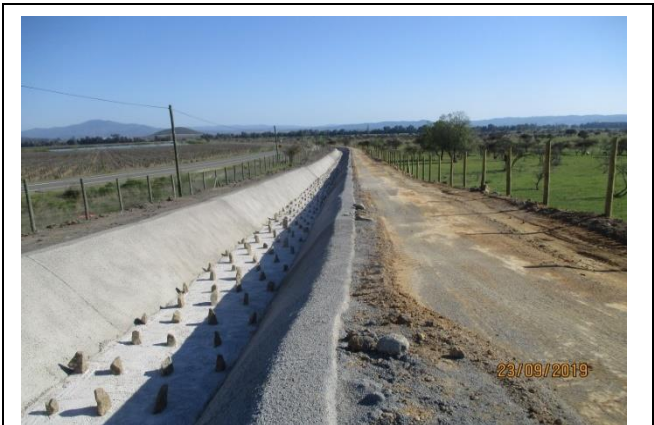
NCS; ramal “El Molino 1; disipadores “tresbolillo” en fondo canal (km 0,310 –km 0,64)
