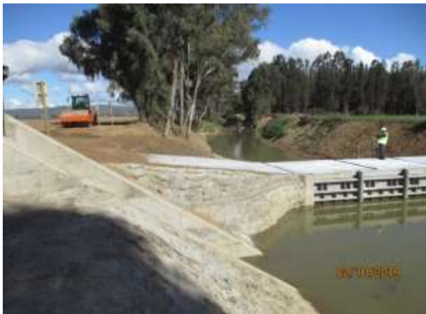
Poza Quiahue N° 2 de ramal “El Molino”; vista general
