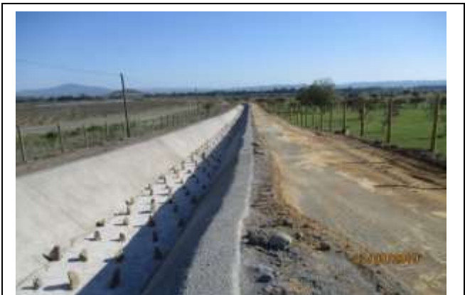
NCS; ramal "El Molino 1; disipadores "tresbolillo" en fondo canal (km 0,310 –km 0,640)
