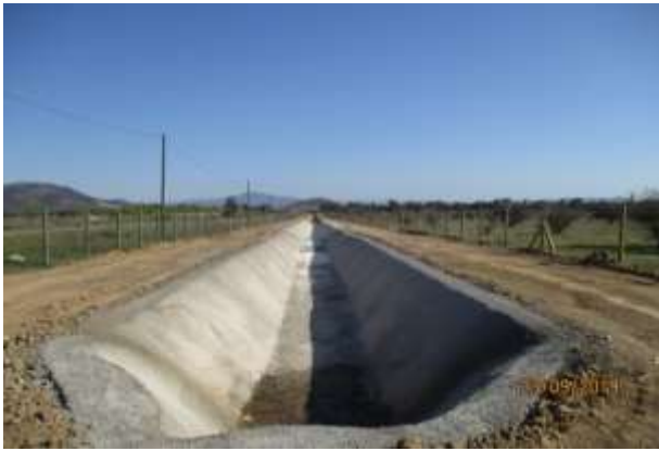
NCS; ramal “El Molino 1; revestimiento canal (km 0,640 – km 1,060)
