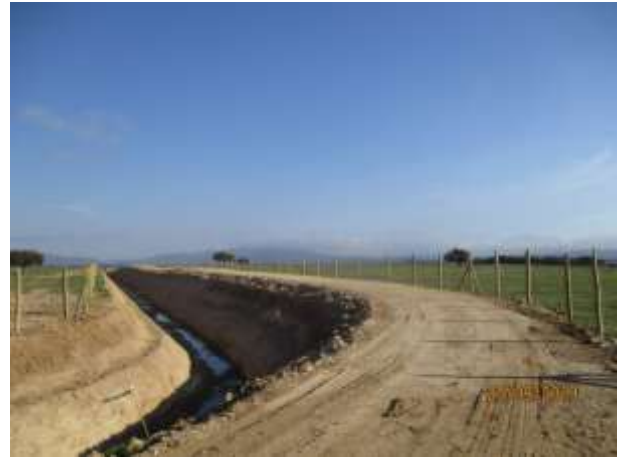
NCS; ramal “El Molino 2.1”; canal en tierra (km 1,250 – km 3,400)
