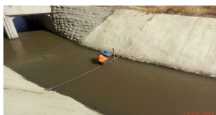
Bocatoma canal Norte Unificado
