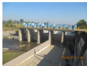
Canal Tenochimbarongo en Boca-toma (Puertas de admisión cerradas desde el 19/12/2018)
