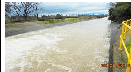
Canal Teno-Chimbarongo en Bocatoma
