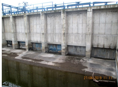
Canal Matriz Nilahue Tramo 1 (Compuertas de admisión cerradas).
