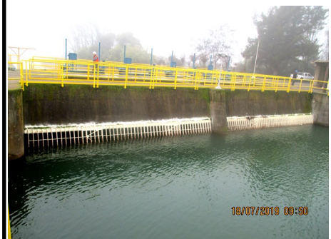
Bocatoma del Canal Teno-Chimbarongo.
