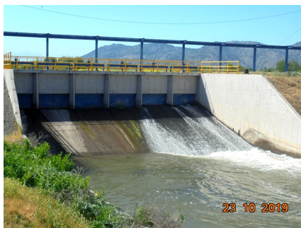
Bocatoma Las Toscas (Compuertas de admisión).
