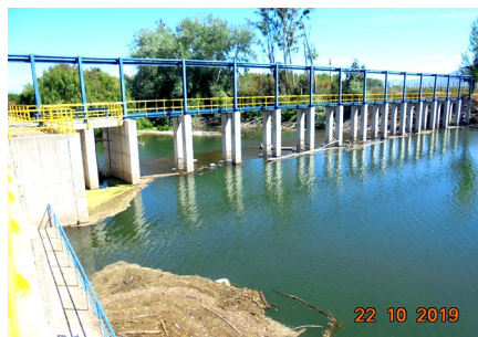
Bocatoma Uva Blanca (barrera en Estero Chimbarongo).
