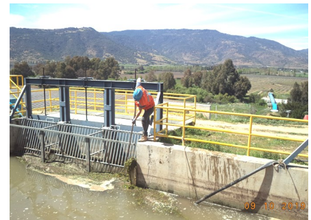
Sifón Nerquihue, limpieza de rejas de la captación.
