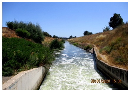
Canal Matriz Nilahue Tramo 1 (en Bocatoma Uva Blanca).
