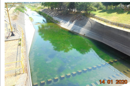
Canal Teno-Chimbarongo en Bocatoma.
