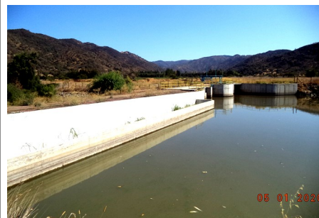
Bocatoma del Canal Norte Unificado.
