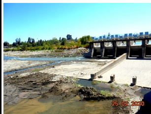
Bocatoma de Canal Teno-Chimbarongo
