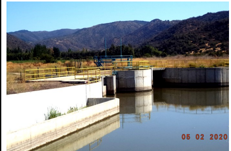
Bocatoma del Canal Norte Unificado.
