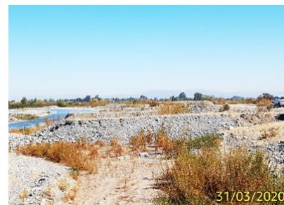
Canal Matriz Nilahue Tramo 2, inspección de aforo.
