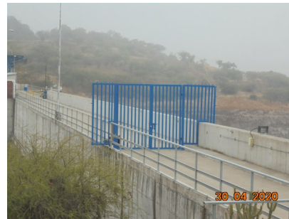
Presa Auxiliar, sin operación.
