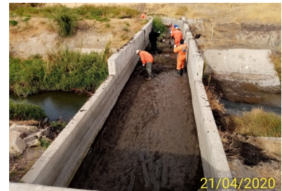
Canal Matriz Nilahue Tramo 2, inspección de actividades de conservación de pasos y canoas.
