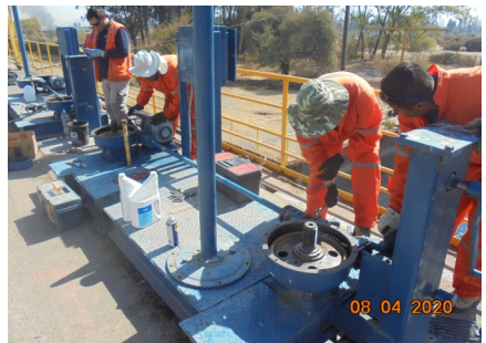
Bocatoma canal Teno-Chimbarongo, conservación y reparación de compuertas.
