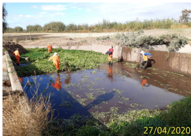
Canal Matriz Nilahue Tramo 1, inspección de actividades de conservación de pasos y canoas.
