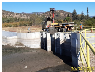
Fase III, Bocatoma canal Norte Unificado, retiro de compuertas planas.
