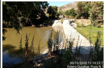
Red de canales Fase III, Poza N°1 en Estero Quiahue.
